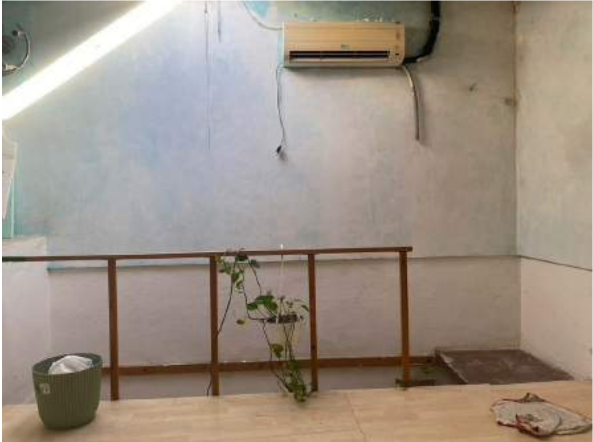
FOTO – SOTTOTETTO (SOFFITTA)
