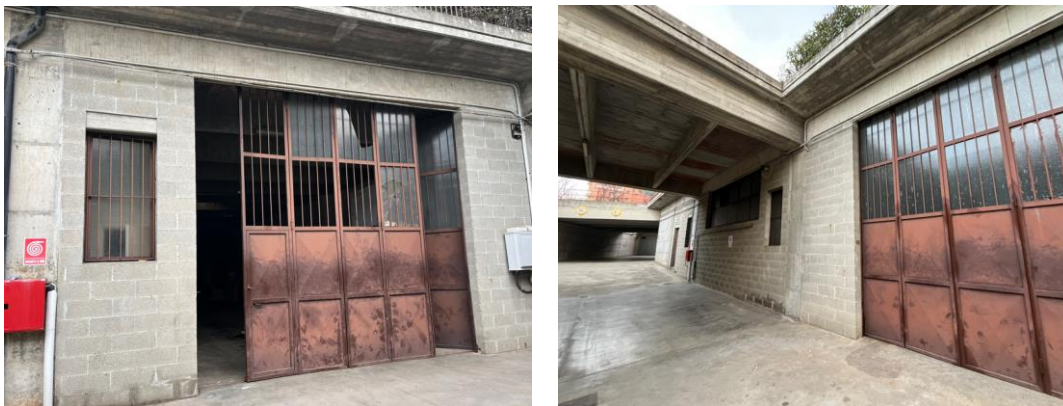
Figura 3 – INGRESSI DA CORSIA DI MANOVRA COMUNE
