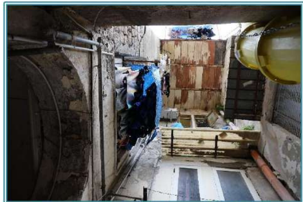
Figura 13 Vista sull'atrio interno del fabbricato
