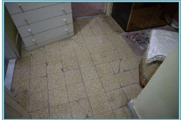
Figura 25 Stato conservativo del pavimento nella camera2
