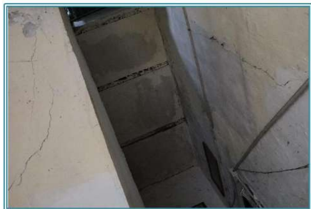
Figura 15 Vano scala comune per accedere ai piani 3°e4°
