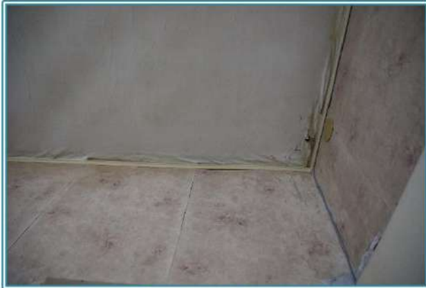
Figura 36 Particolare del controsoffitto in tela nel salone
