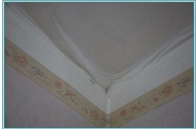
Figura 31 Particolare del controsoffitto in tela nella camera1
