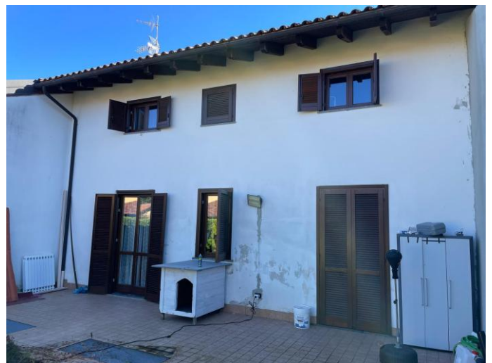
Foto 3 – vista del fronte di nord
