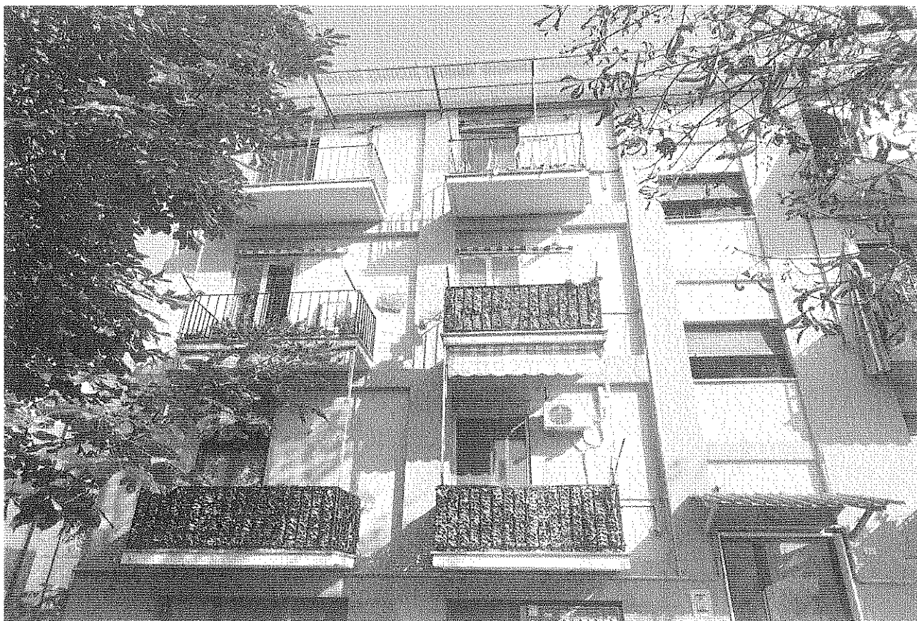
FOTO 2 – Particolare prospetto principale: vista balconi appartamento ultimo piano
