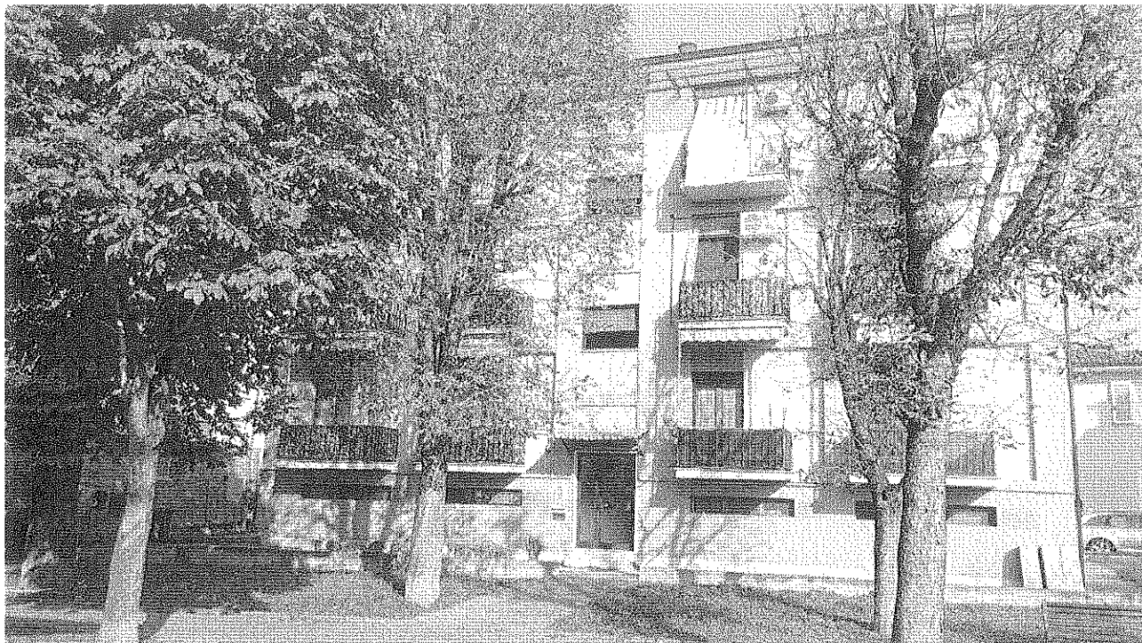
FOTO 1 – Prospetto principale fabbricato in via E. Fermi, 14
