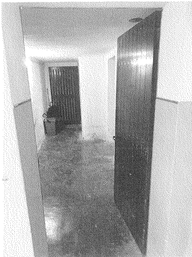
FOTO 14 – Vista corridoio cantine
