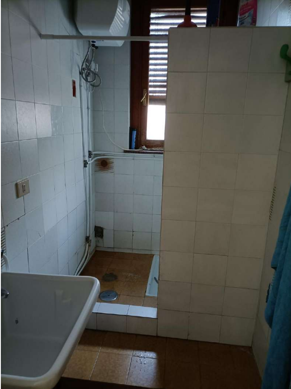
Foto 6. Vista del WC.
