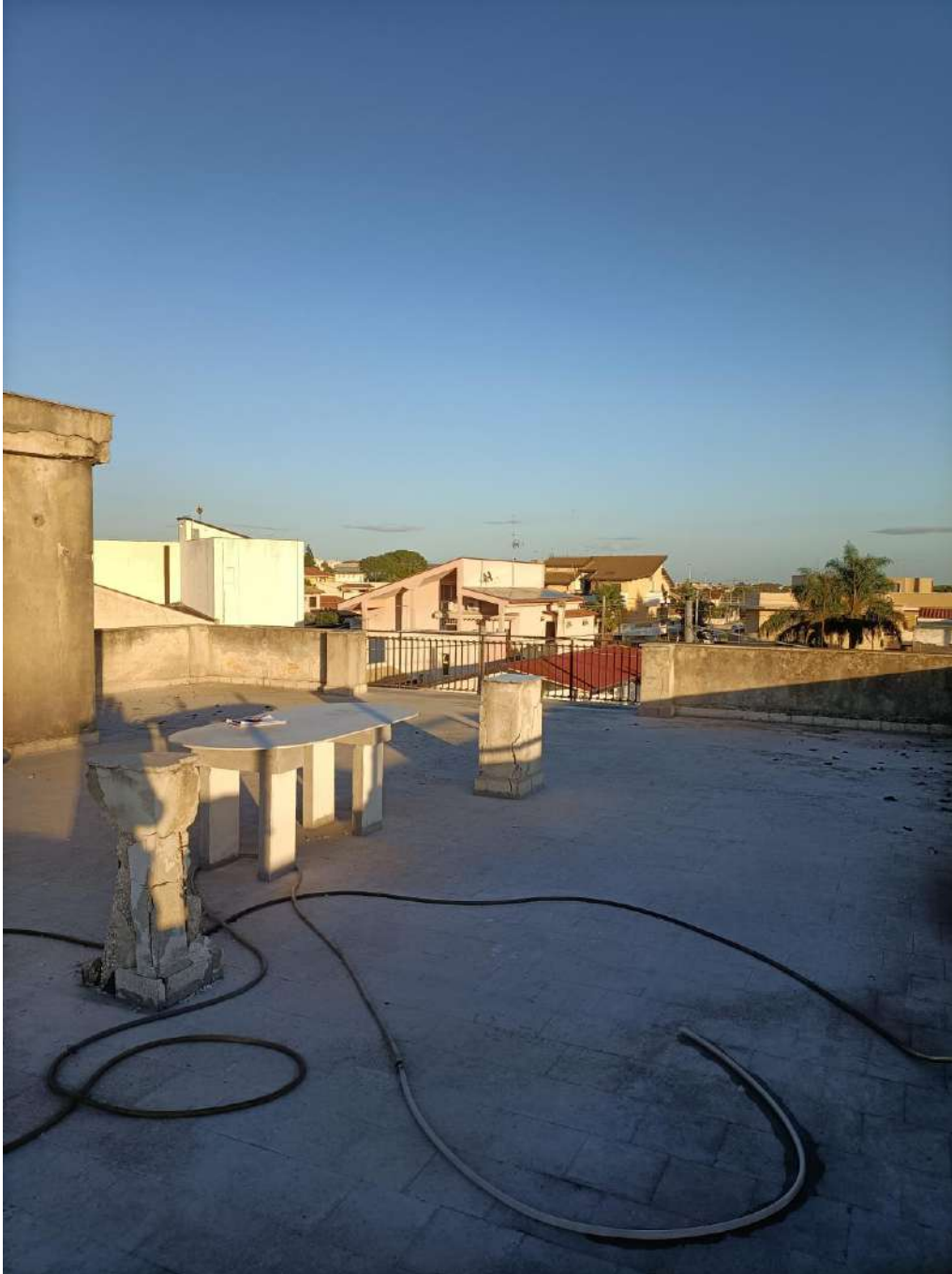
Foto 12. Vista della terrazza.
