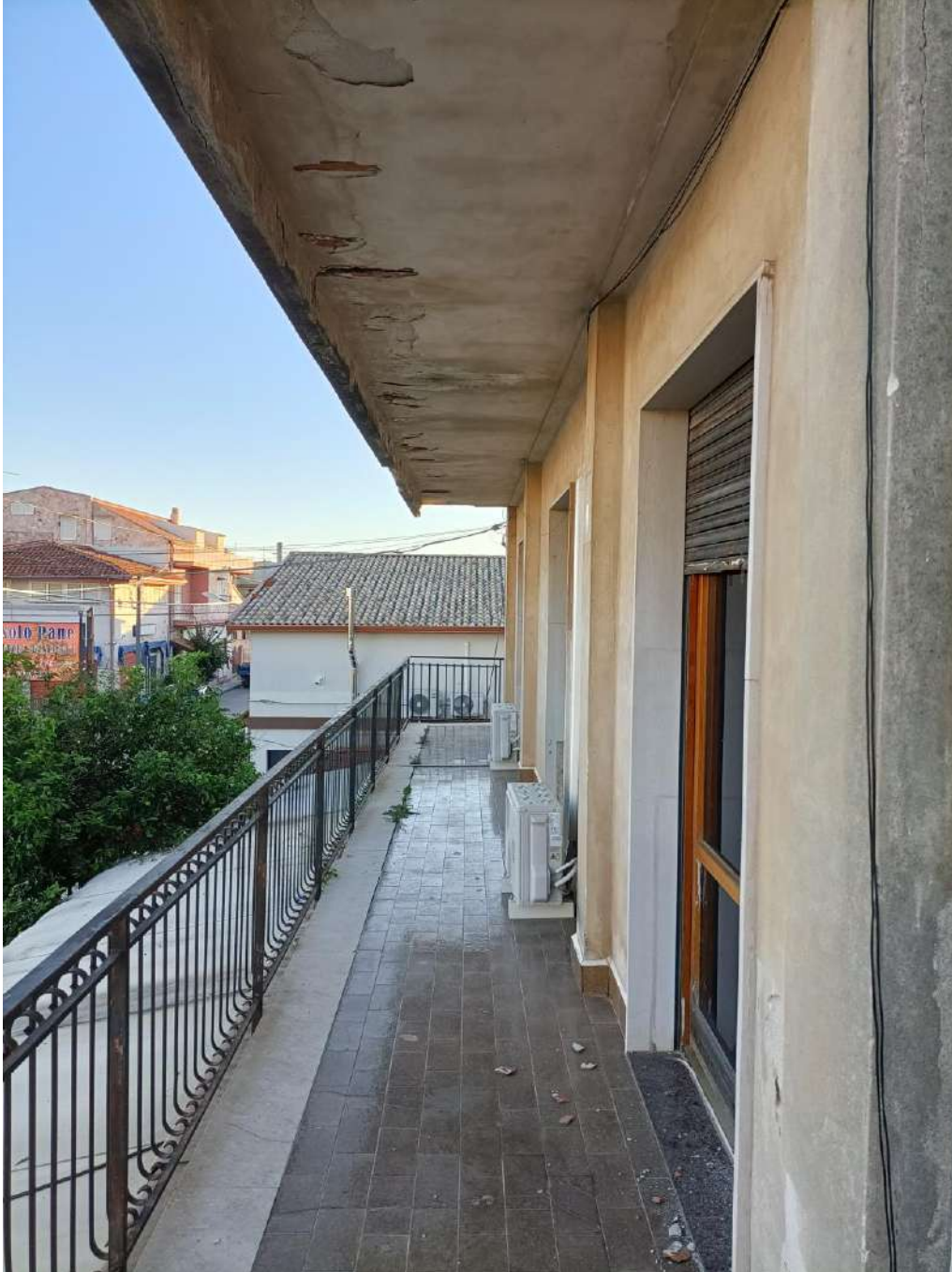
Foto 9. Vista del balcone sul lato est.
