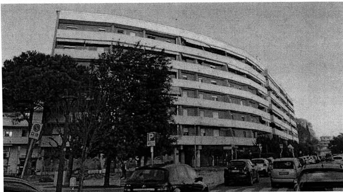
Vista del fabbricato condominiale dalla pubblica via – lato visibile nella foto è il lato ovest e sud
