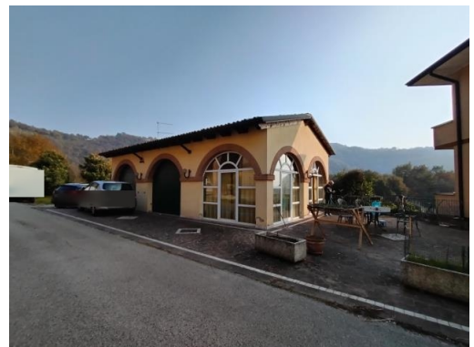
Vista esterna– prospetto nord/ovest edificio accessorio
