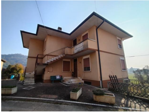
Vista esterna– prospetto nord/ovest – edificio residenziale
