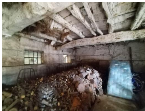
Vista interna DEPOSITO (porzione catastale foglio 31 mappale 381)
