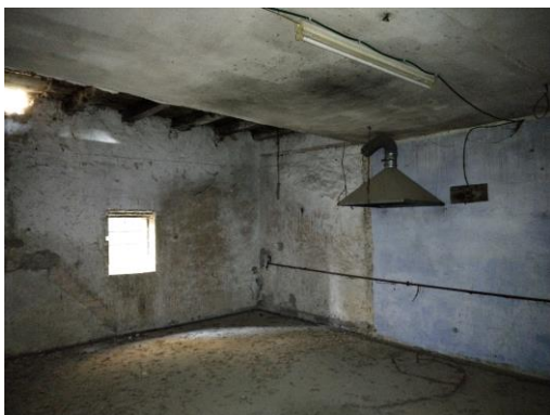
Vista interna SOFFITTA (porzione catastale foglio 31 mappale 258 subalterno 1)
