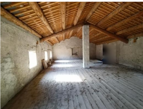
Vista interna SOFFITTA (porzione catastale foglio 31 mappale 131 subalterno 1)
