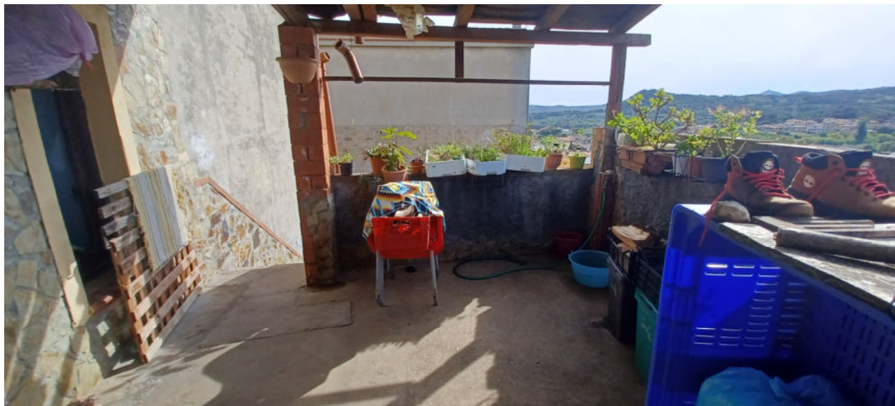
FOTO 14 TERRAZZA CON LOGGIATO D'ACCESSO AL PRIMO PIANO
