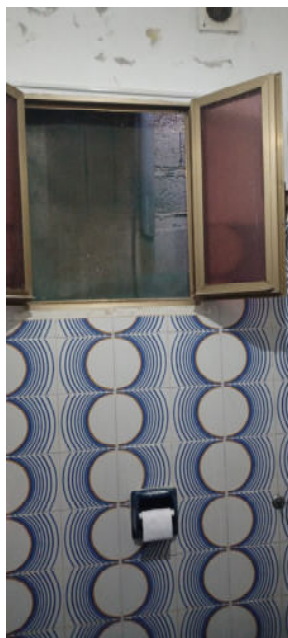
FOTO 12 APERTURA AL POZZO DI LUCE
