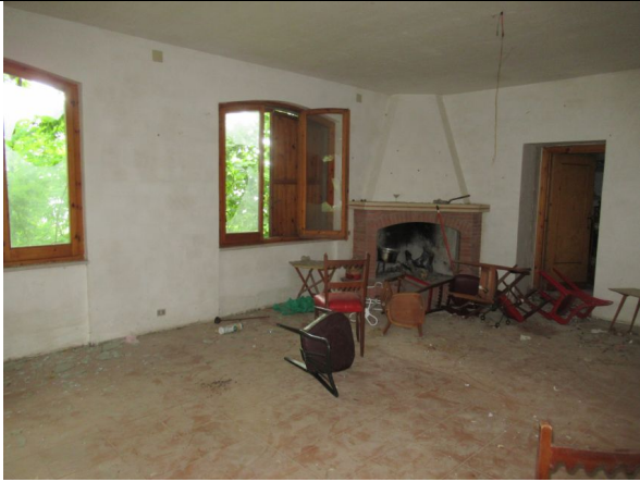
Foto 19 – Interno – Piano terra
