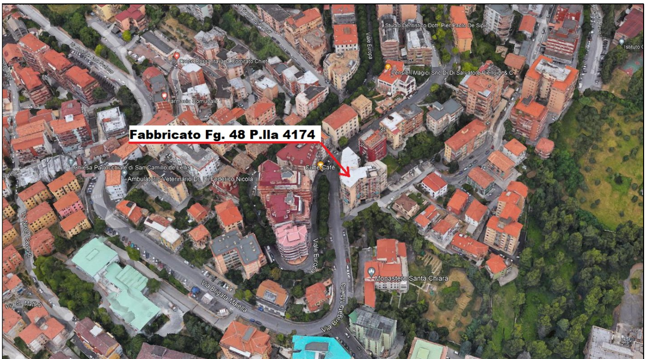
Immagine da Google Earth – Fabbricato condominiale in Via XXXX
