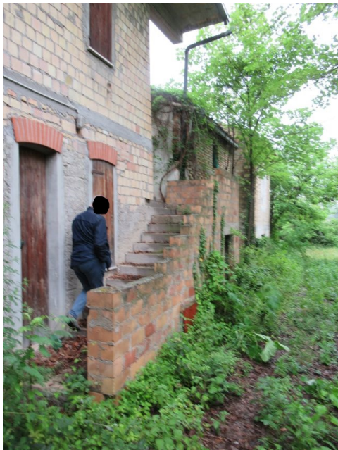
Foto 21 – Scala esterna di accesso al P. 1°
