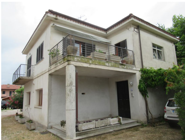
Foto 25 – Esterno fabbricato (appartamento P. 1°)
