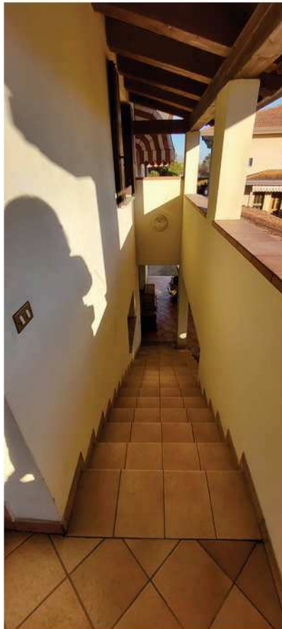
19 _ Scale esterne di collegamento fra i piani del fabbricato secondario
