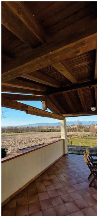
20 _ Particolare porticato al piano primo del fabbricato secondario - vista verso Nord
