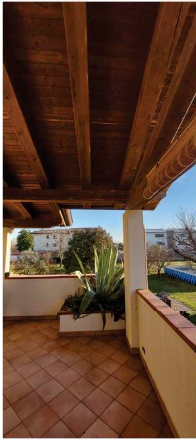
21 _ Particolare porticato al piano primo del fabbricato secondario - vista verso Sud
