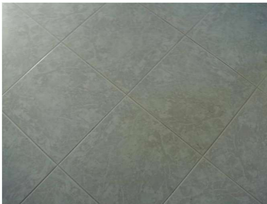
Fig.61– Foto interno : particolare pavimento P2°
