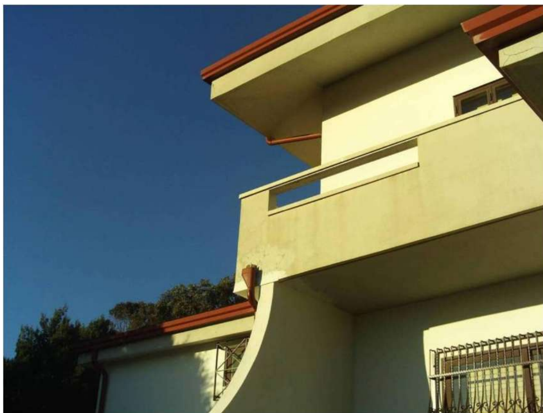
Fig.23 – Foto esterna : Individuazione del fabbricato Foglio n. 5 Particella n.87
