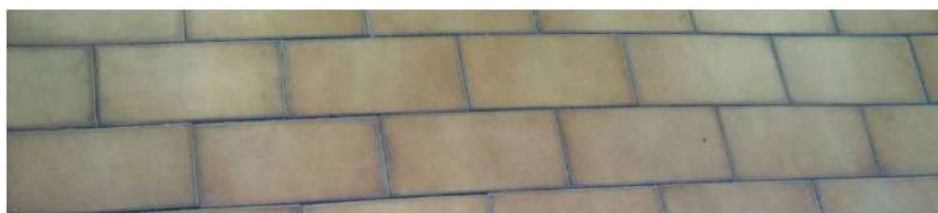
Fig. 16 – Foto pavimentazione terrazza esterna
