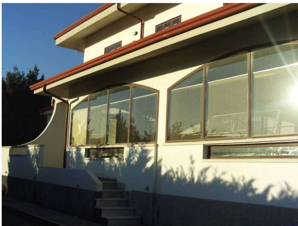
Fig.22– Foto esterna : Individuazione del fabbricato Foglio n. 5 Particella n.87
