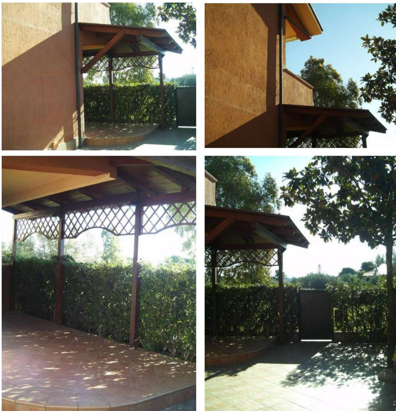
Fig. 6 – Foto esterno(Cancelletto d’ingresso e porticato)
