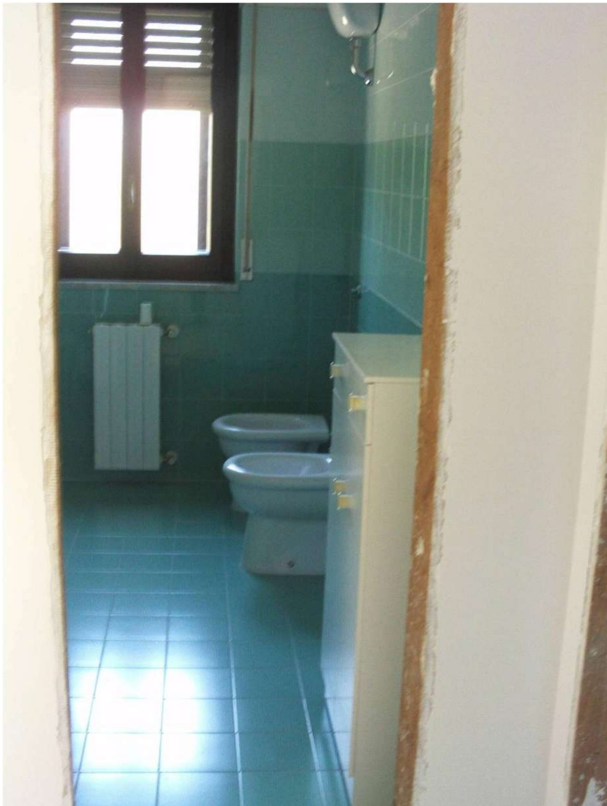
Fig.65 – Foto interno : bagno P2°
