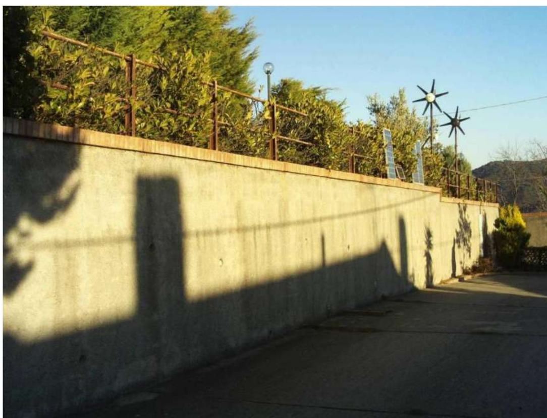
Fig.35 – Foto esterna : mura di contenimento su strada di risalita
