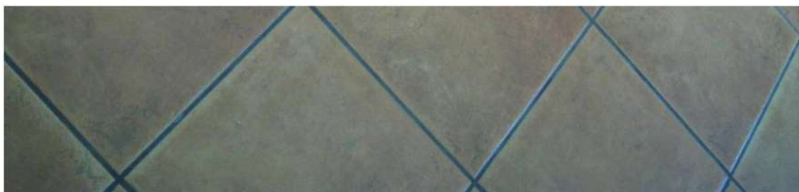
Fig. 7 – Foto pavimentazione esterna
