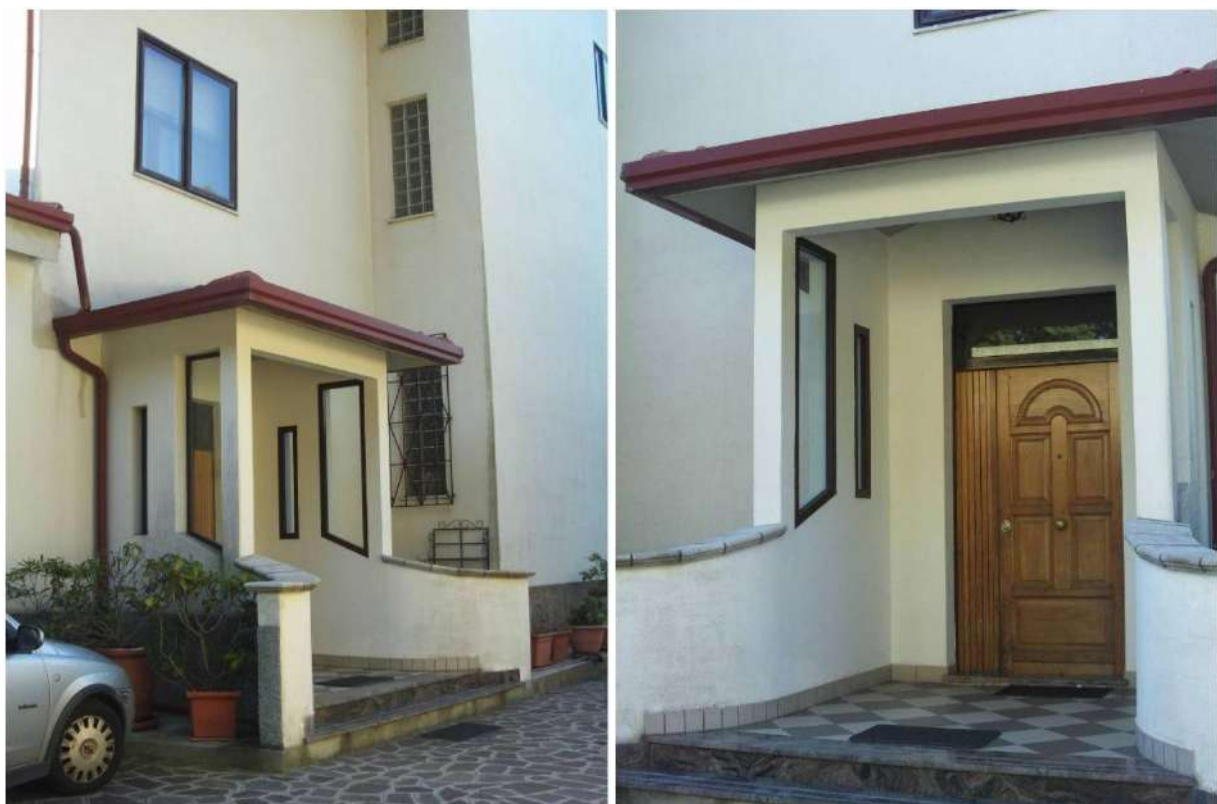
Fig.25 – Foto esterna : Portone d'ingresso alla villa
