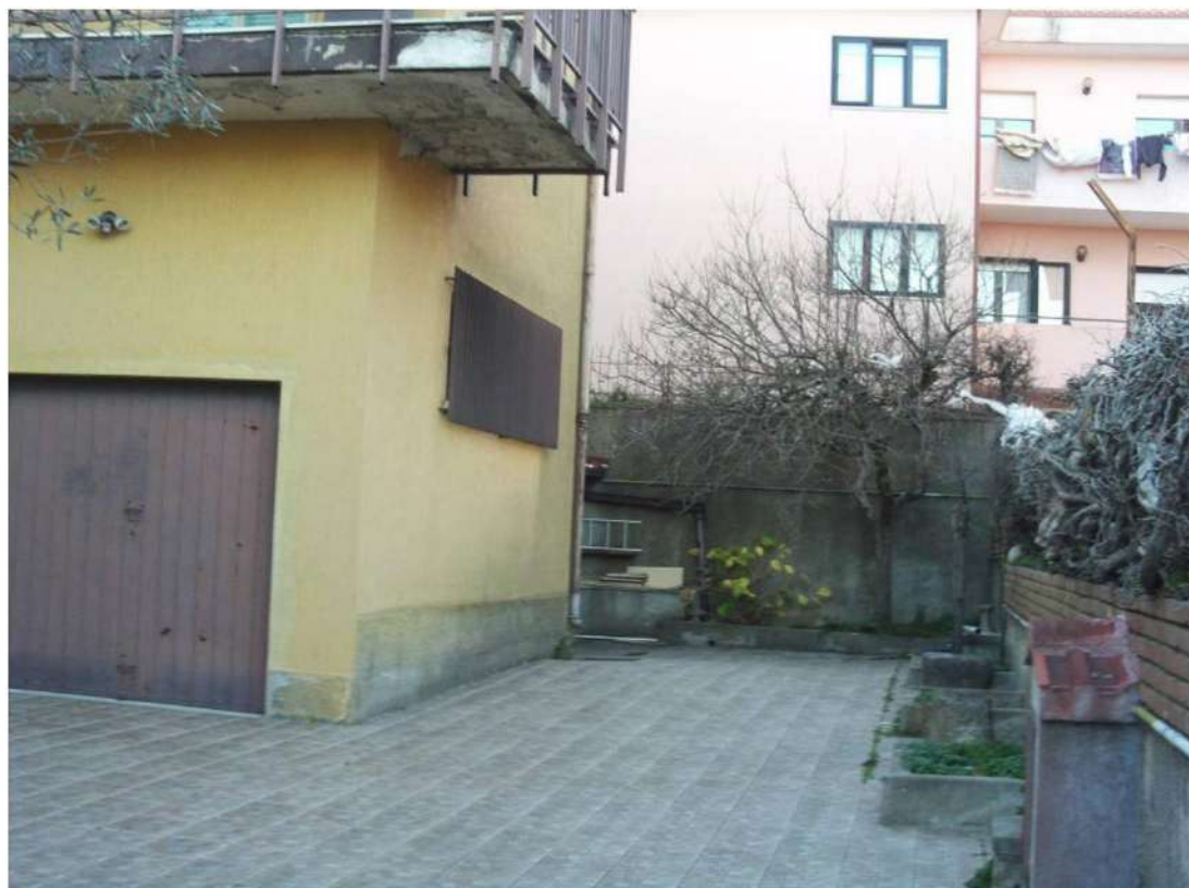
Fig.99– Foto esterno : garage – sub 4 piano T
