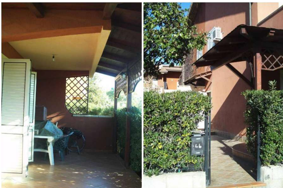
Fig. 5 – Foto esterno(Cancelletto d’ingresso e porticato)
