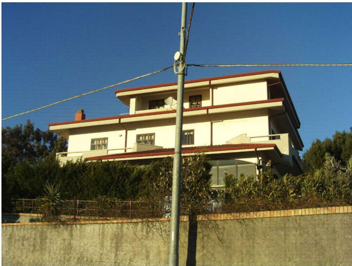
Fig.21 – Foto esterna : Individuazione del fabbricato Foglio n. 5 Particella n.87
