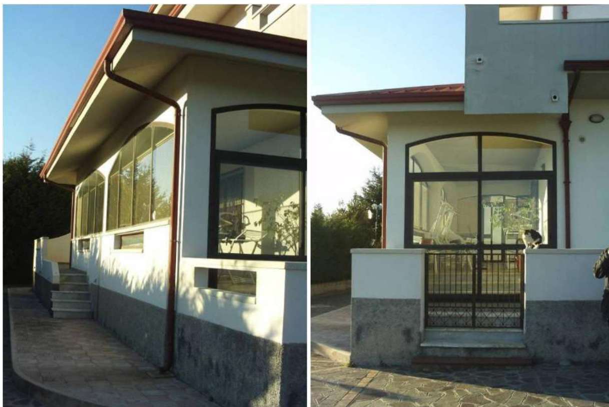
Fig.24 – Foto esterna : Individuazione del fabbricato Foglio n. 5 Particella n.87
