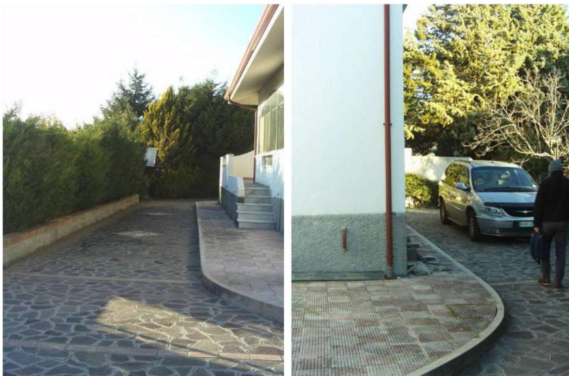
Fig.32 – Foto esterna : piazzale esterno
