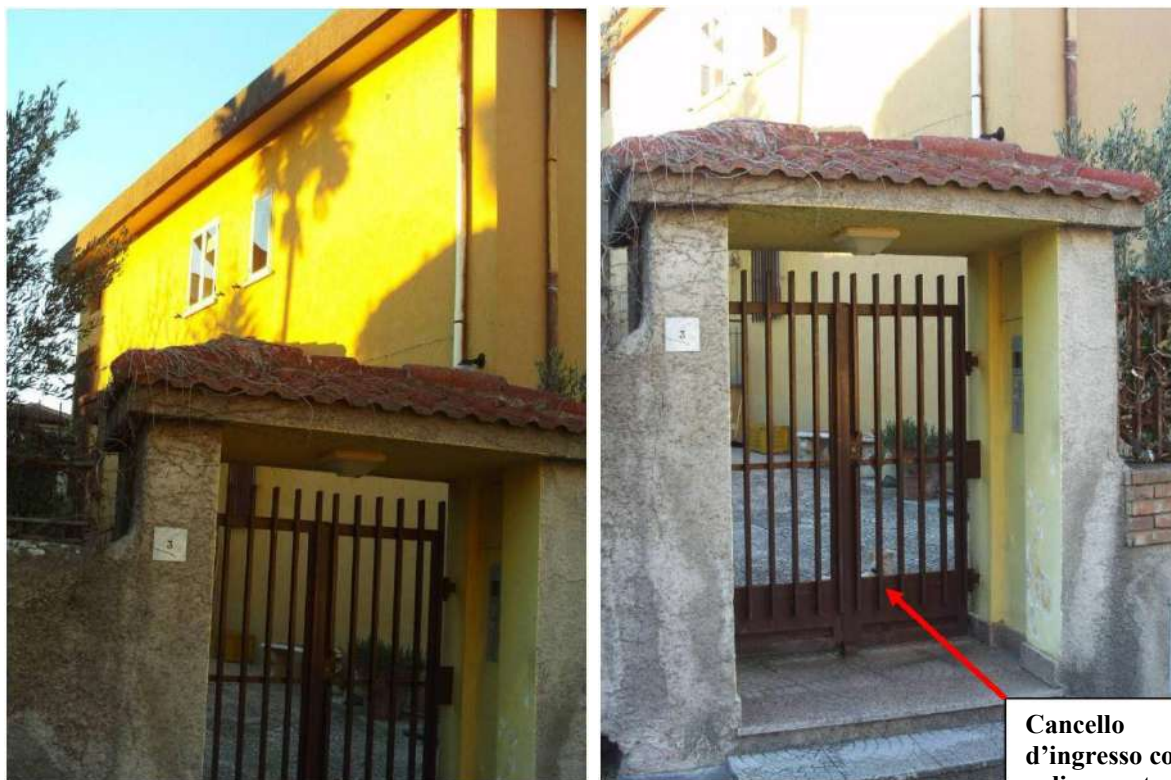
Fig.69– Foto esterno palazzina _ cancello ingresso pedonale
