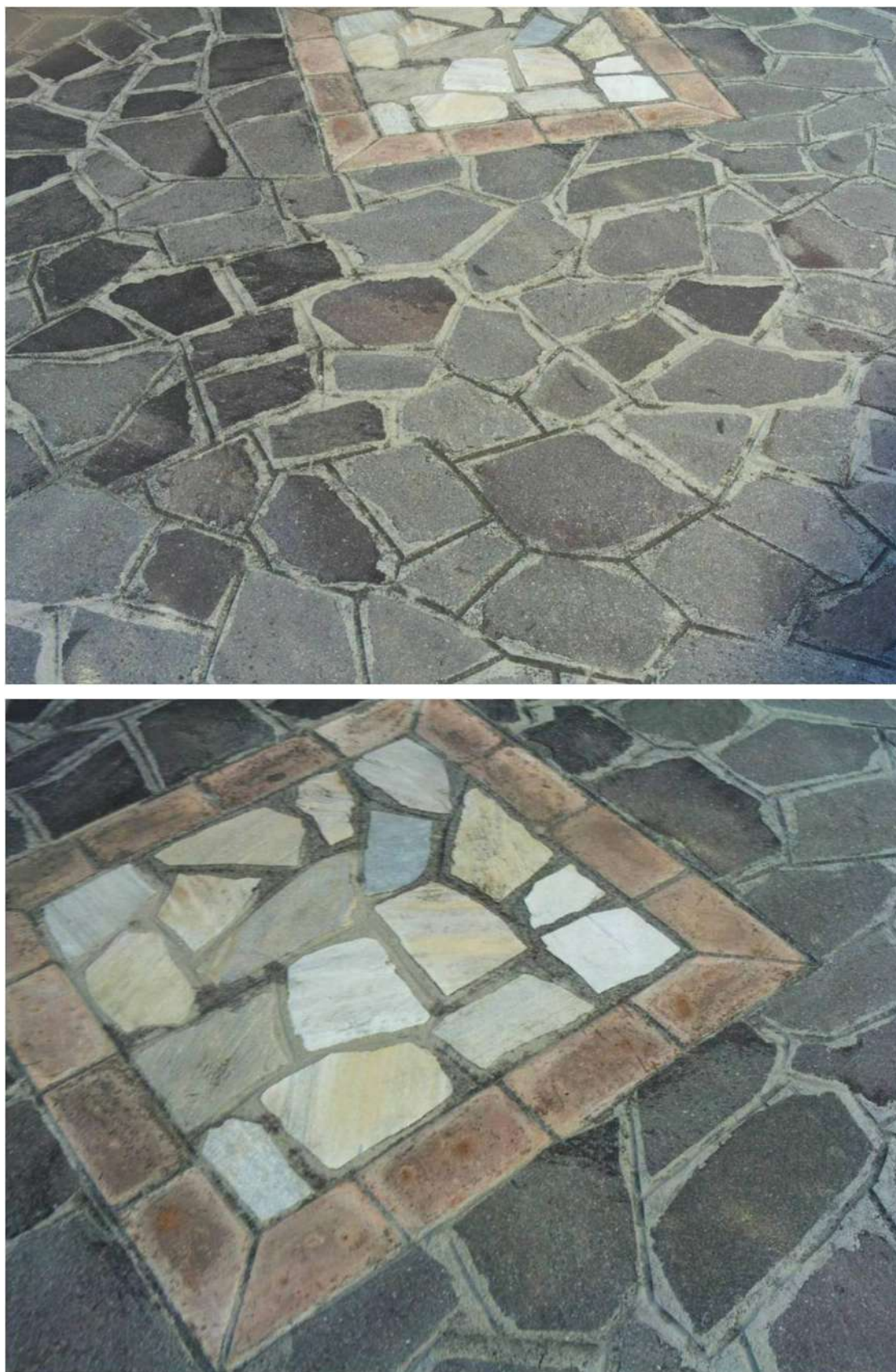
Fig.31 – Foto esterna :particolare porfido piazzale esterno
