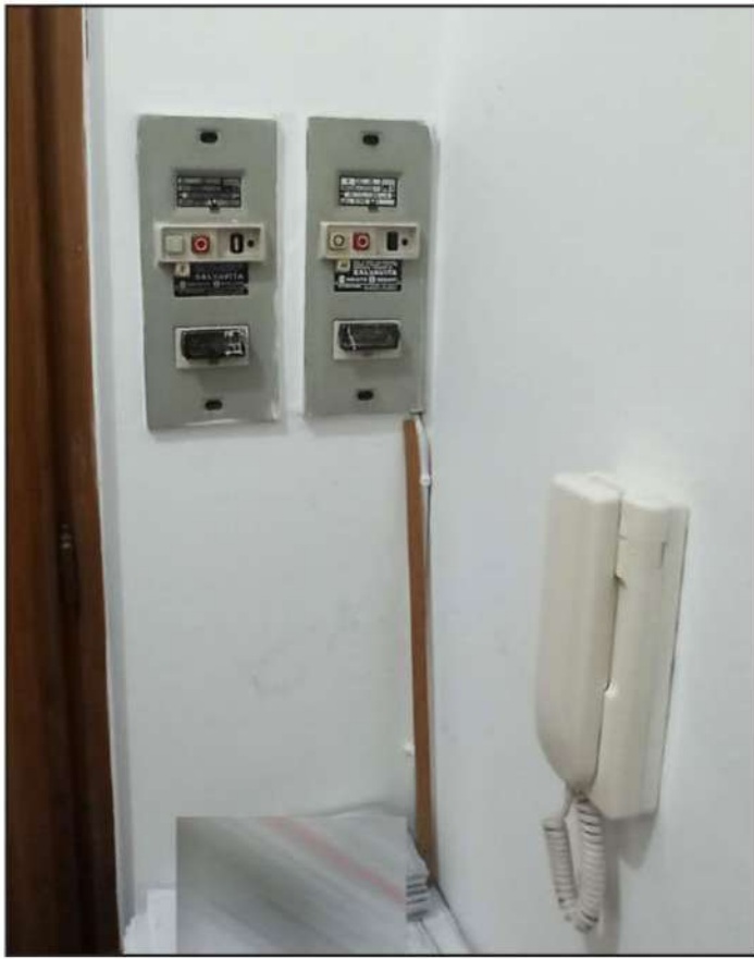
Foto 44 : impianti - quadro elettrico e citofono
