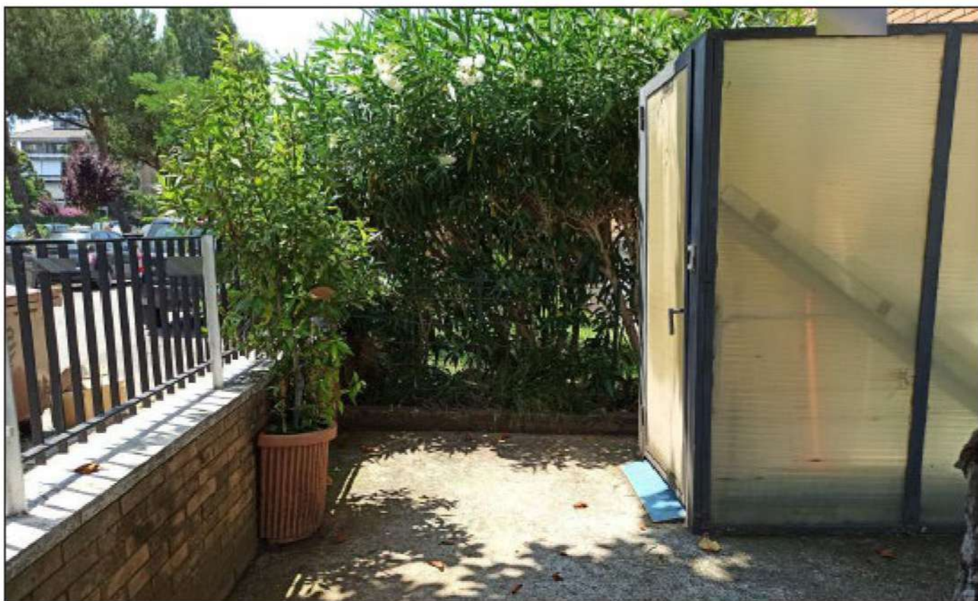
Foto 8 : esterno - vista del cortile con l'elevatore disabili
