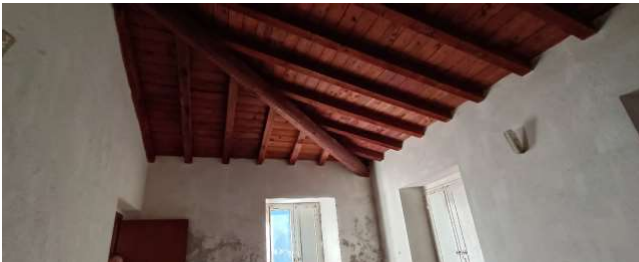
Foto 18) M.967 – Struttura falde del tetto.
