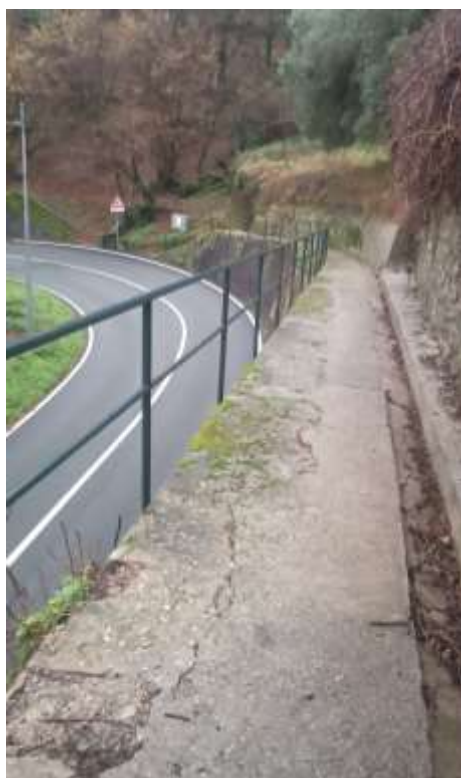
Foto 2) Strada vicinale di accesso
