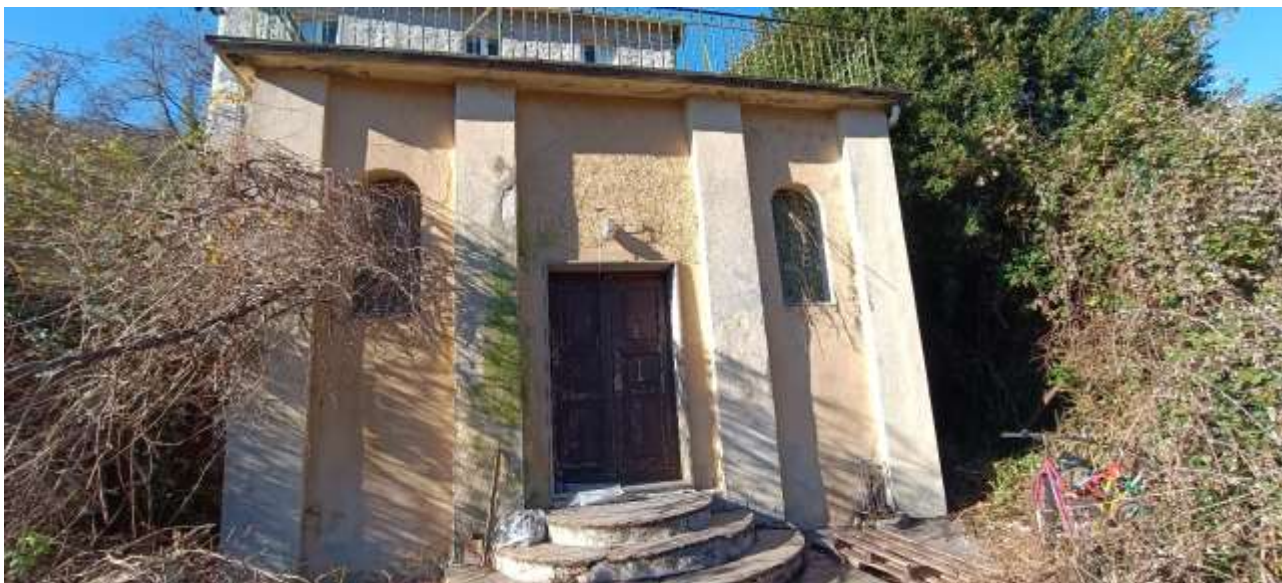
Foto 3) M. 697 - P.T. facciata est
