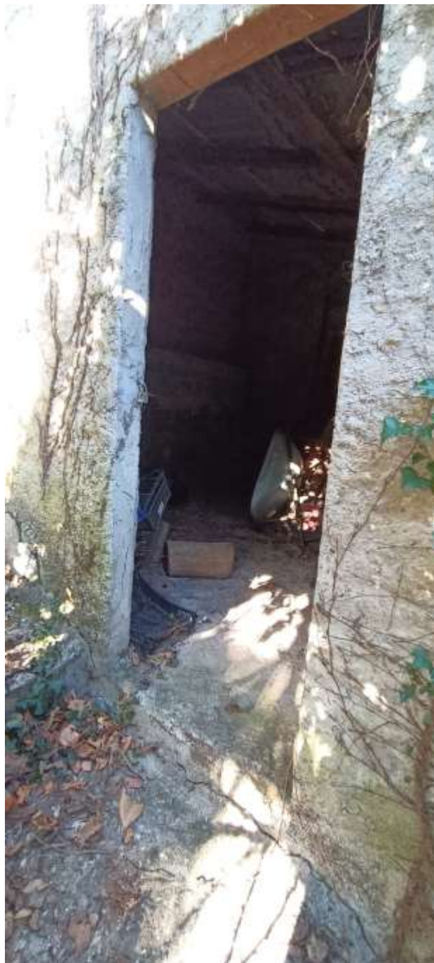
Foto 38) M.753 ingresso PT
