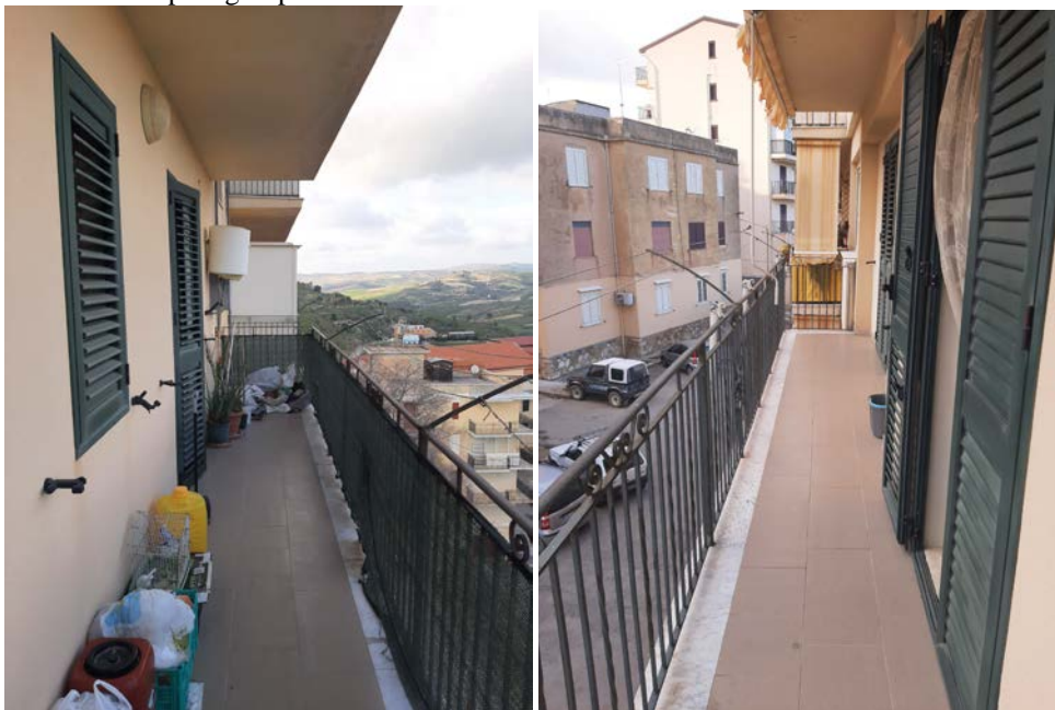
Foto n° 12 Vista dei due balconi
