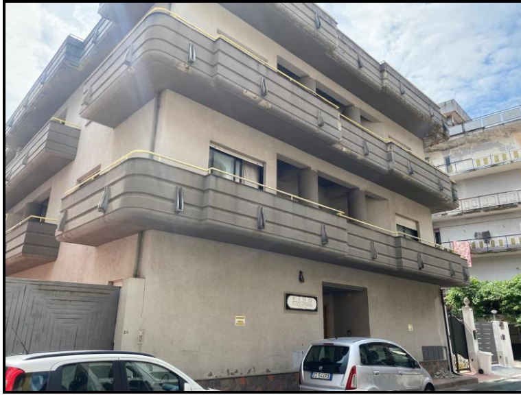
Viste esterno edificio (appartamento)
