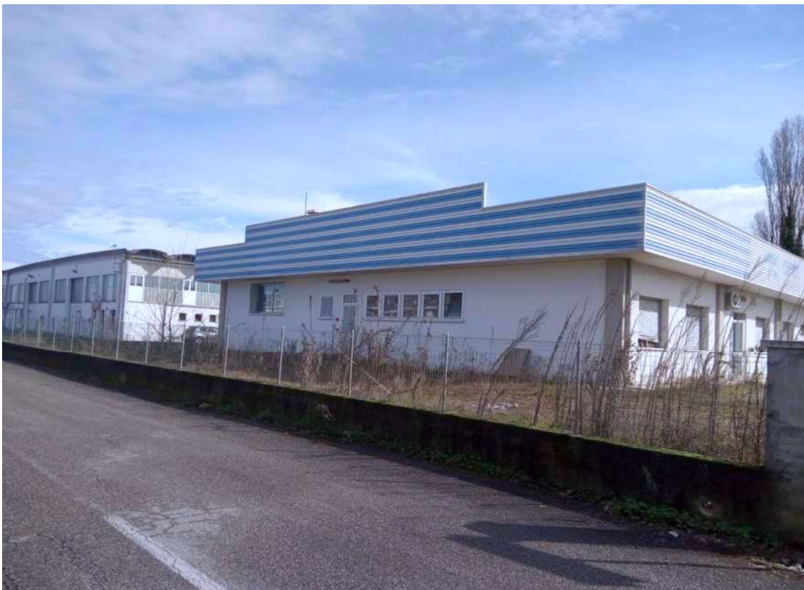
Foto 3: Vista capannone da Sud-Ovest
