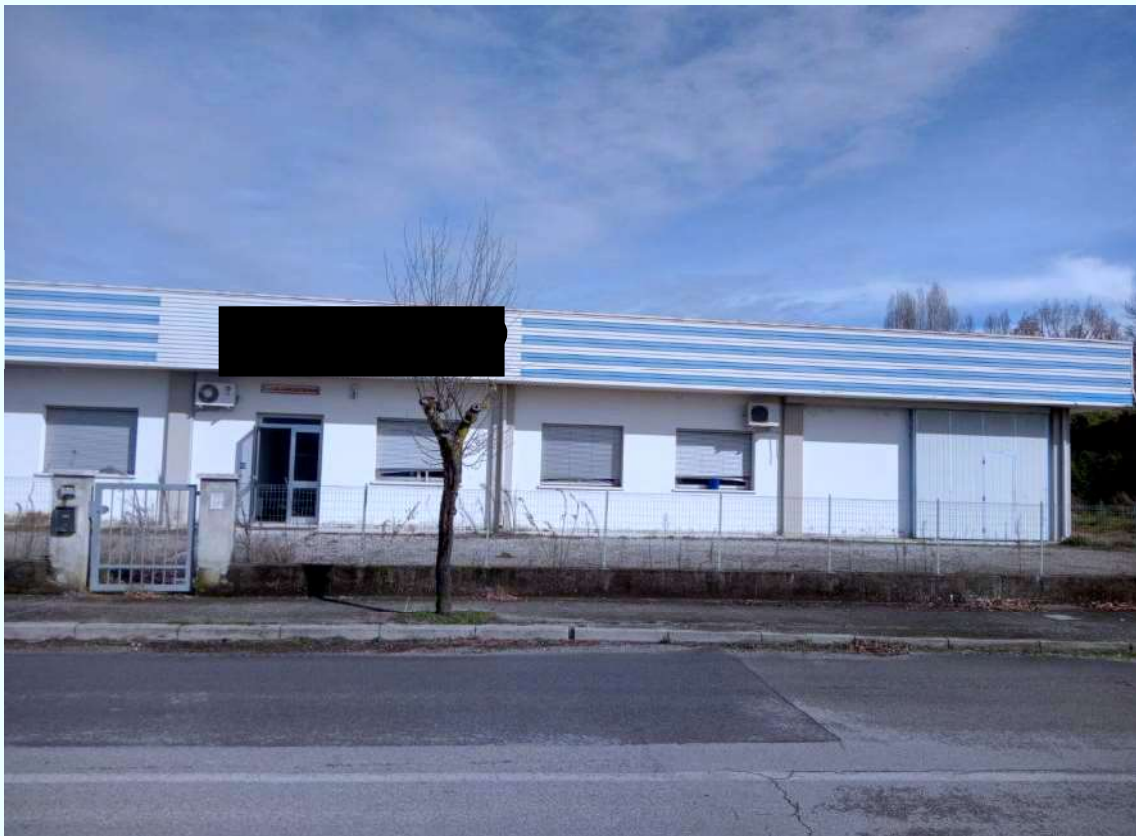
Foto 1: Prospetto Sud capannone
