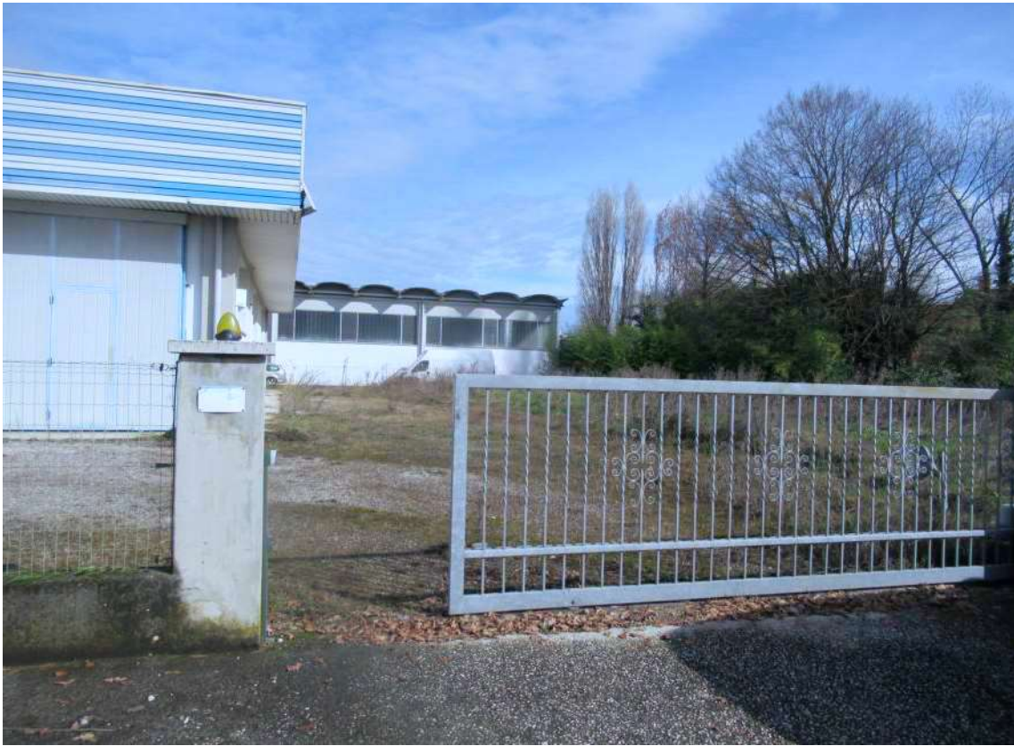
Foto 2: Ingresso carraio verso Est
