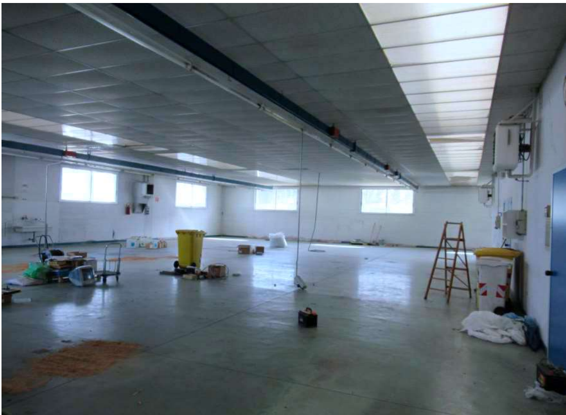
Foto 9: Interno laboratorio visto da Sud-Ovest
