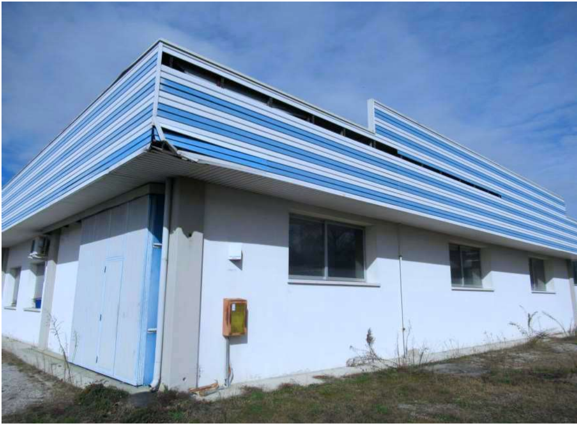
Foto 4: Vista capannone da Sud-Est
