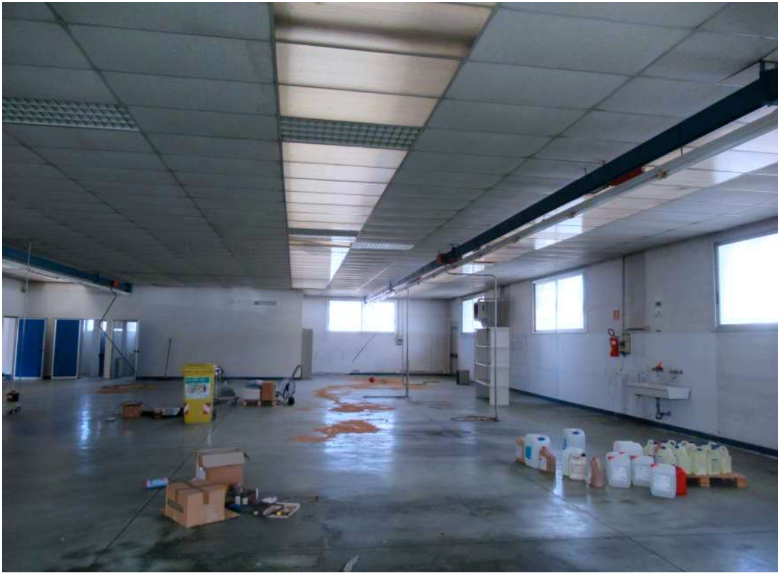
Foto 9: Interno laboratorio visto da Nord-Est
