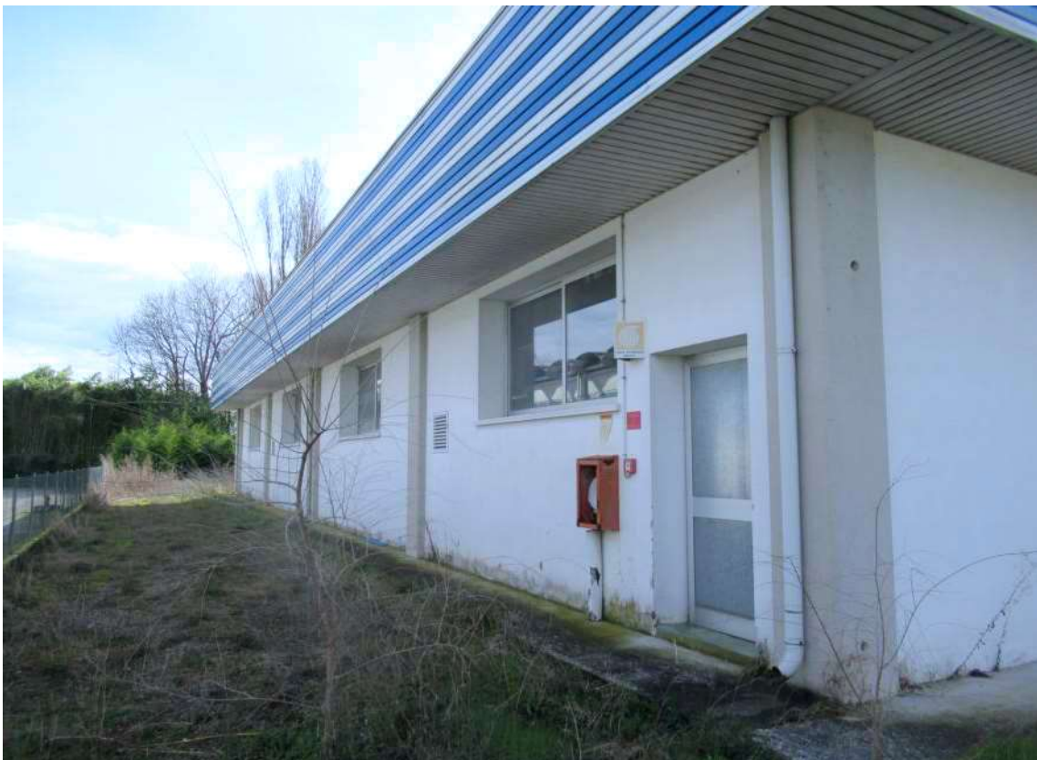
Foto 5: Vista da Nord
