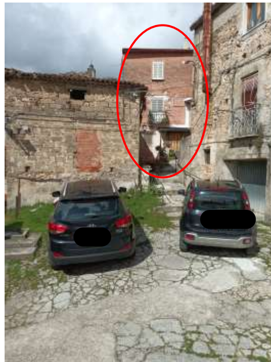
FOTO 5- Vista accesso al Fabbricato
