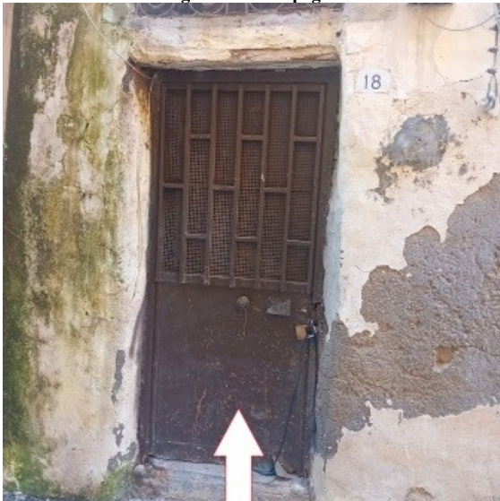
Figura 14 accesso al deposito al piano terra al civico n.18 di via Rosselli in Torre Annunziata
