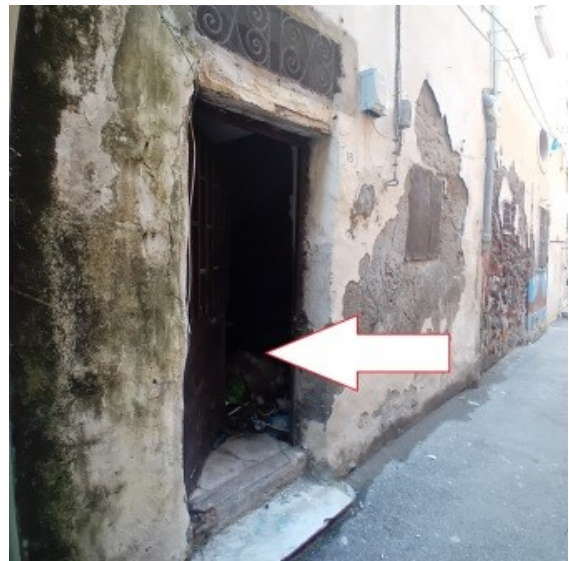
Figura 4 deposito al piano terra al civico n.18 di via Rosselli in Torre Annunziata
