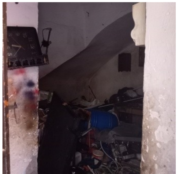
Figura 17 deposito al piano terra
