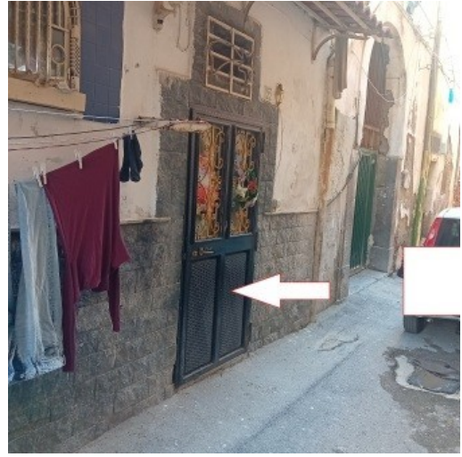
Figura 7 accesso all'appartamento al piano terra al civico n.22 di via Rosselli in Torre Annunziata
