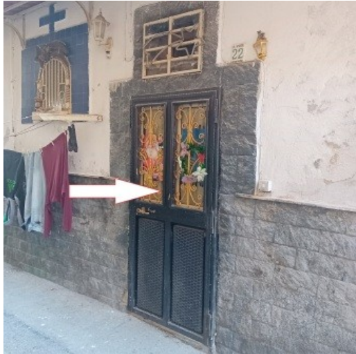
Figura 6 accesso all'appartamento al piano terra al civico n.22 di via Rosselli in Torre Annunziata
