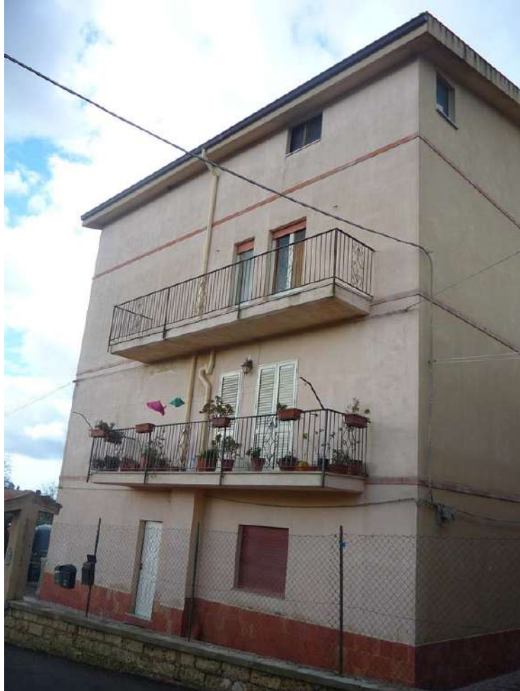
FOTO N. 2 – PROSPETTO SUD-OVEST – INGRESSO
