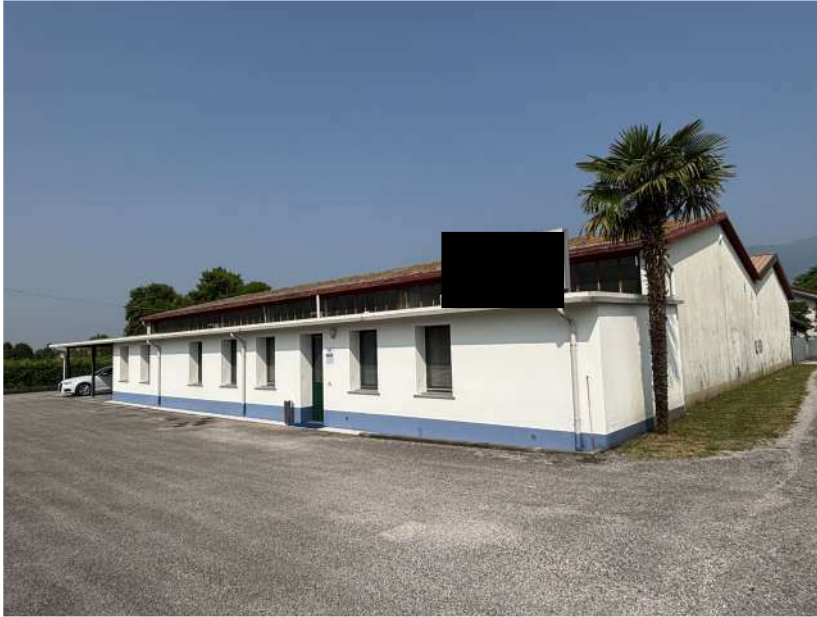
Vista esterna facciata principale fabbricato
