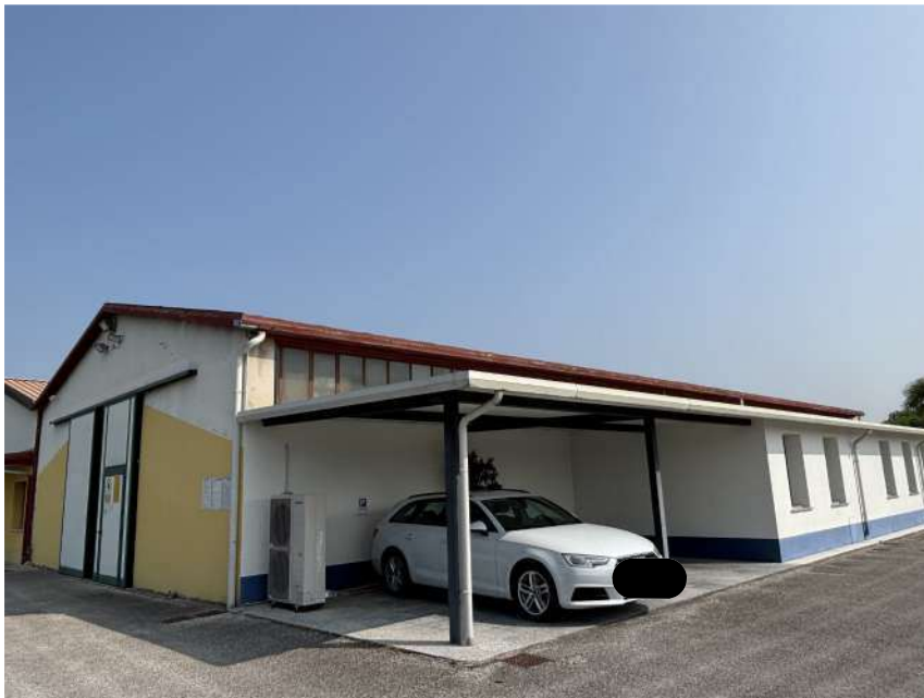
Vista esterna laterale da interno proprietà
