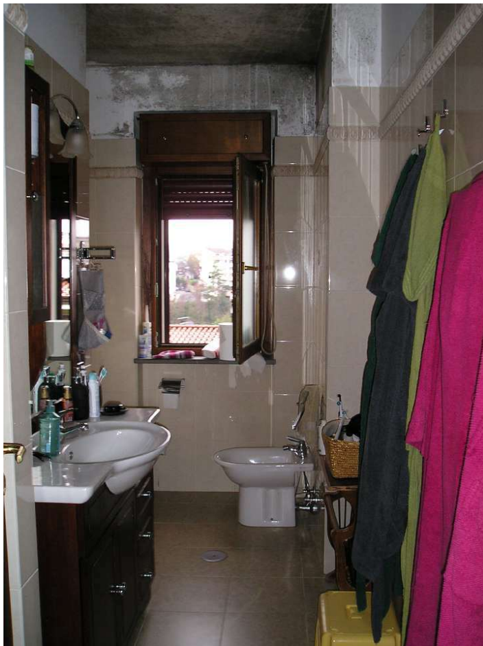
Foto n. 19: Bagno – particolare problema di condensa
