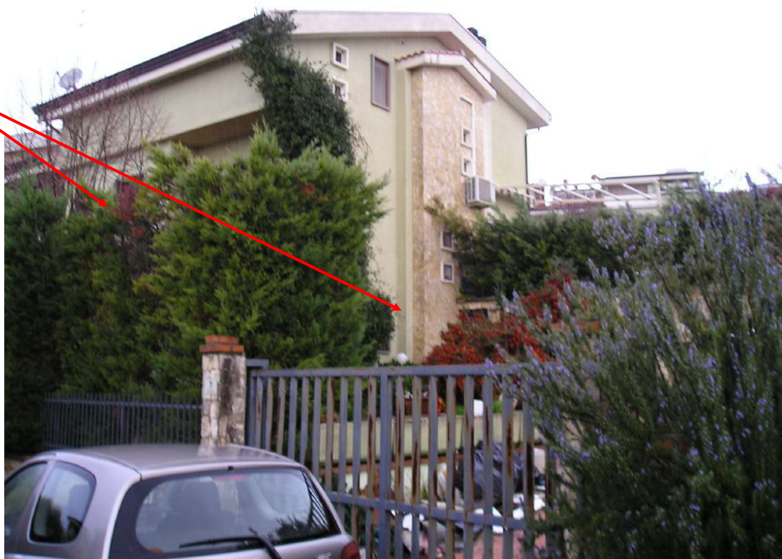
Foto n. 3: Fabbricato di cui fa parte l'immobile pignorato
