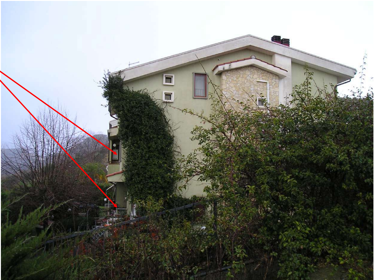
Foto n. 4: Fabbricato di cui fa parte l'immobile pignorato
