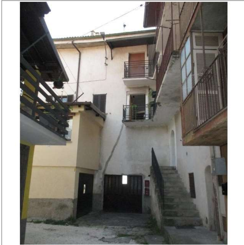
- Complesso immobiliare e appartamento al 2° e 3° piano - Fronte nord -
