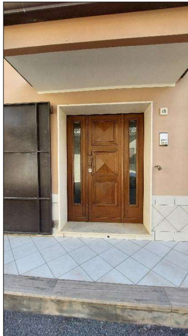
Portone di ingresso al fabbricato
