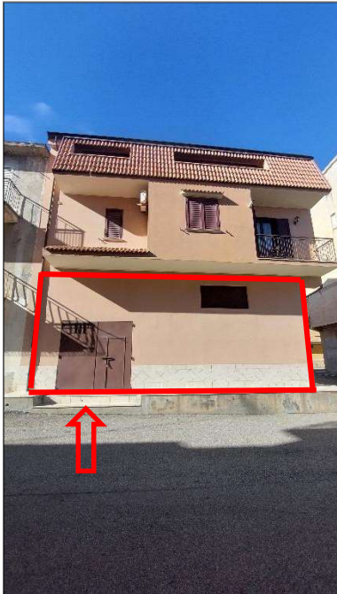
Ingresso su Via S. Allende
