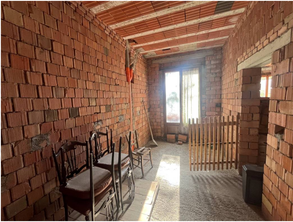
23. Magazzino in stato al grezzo
