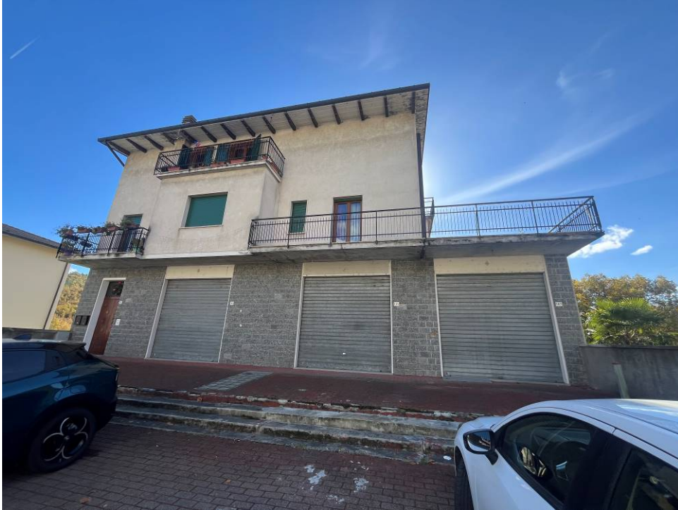
1. Fronte del fabbricato da via Porrettana
