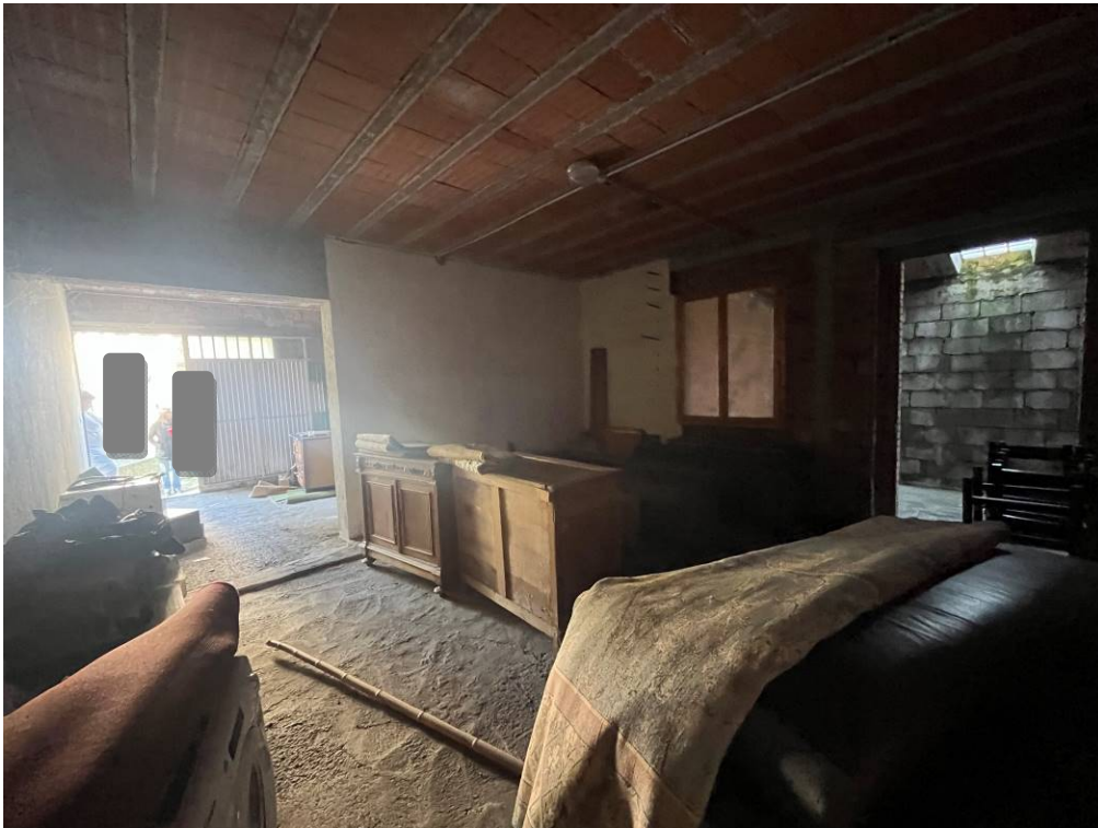
26. Magazzino in stato al grezzo
