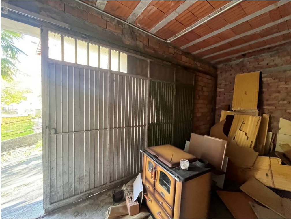
25. Accesso al magazzino
