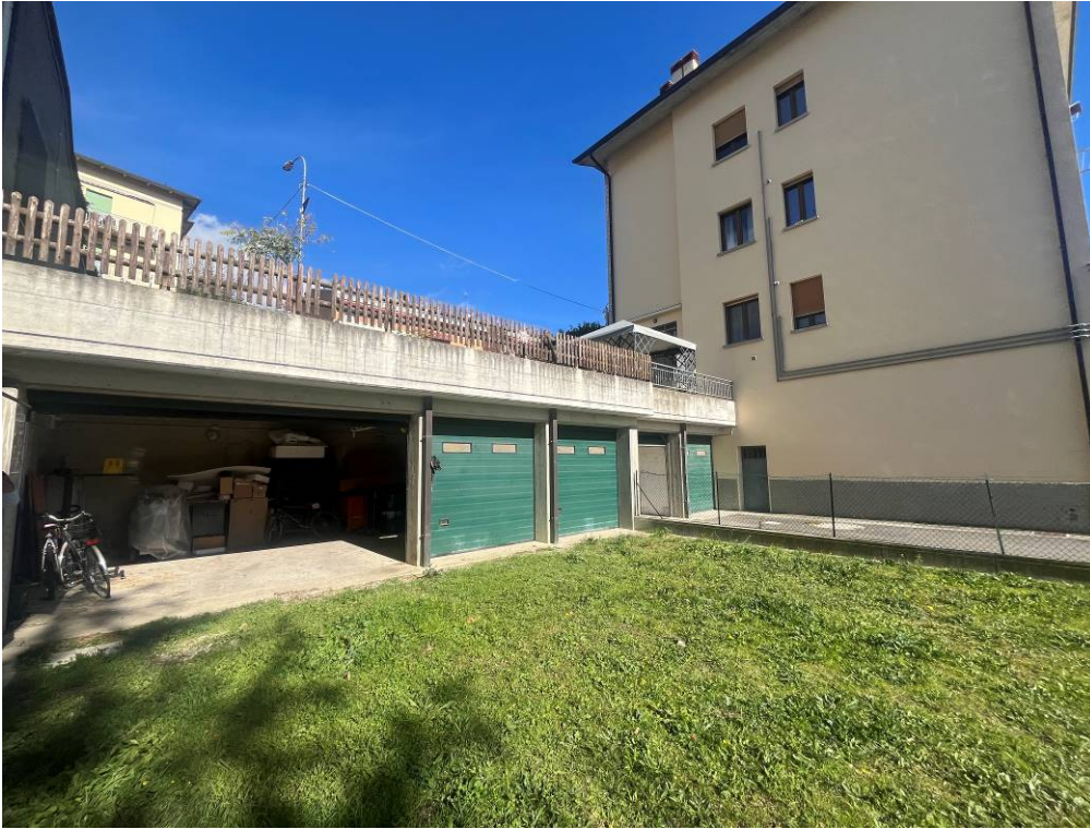
19. Vista esterna dell' autorimessa
