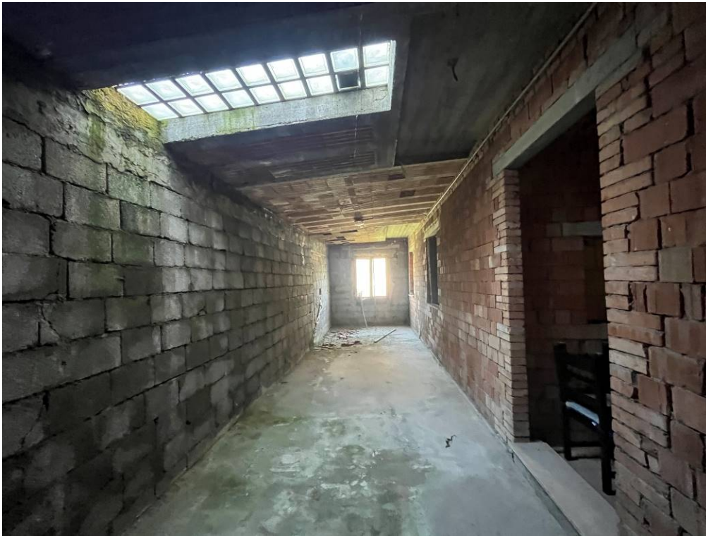
27. Magazzino (porzione a monte)
