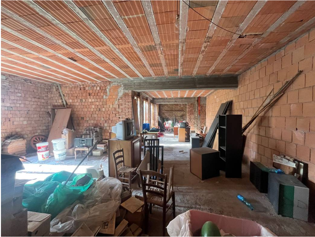
21. Magazzino in stato al grezzo
