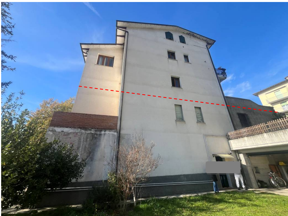
2. Vista laterale del fabbricato – si riporta la linea del piano stradale con evidenza dei tre piani fuori terra (terra, primo e secondo sottotetto) e i due livelli sottostrada
