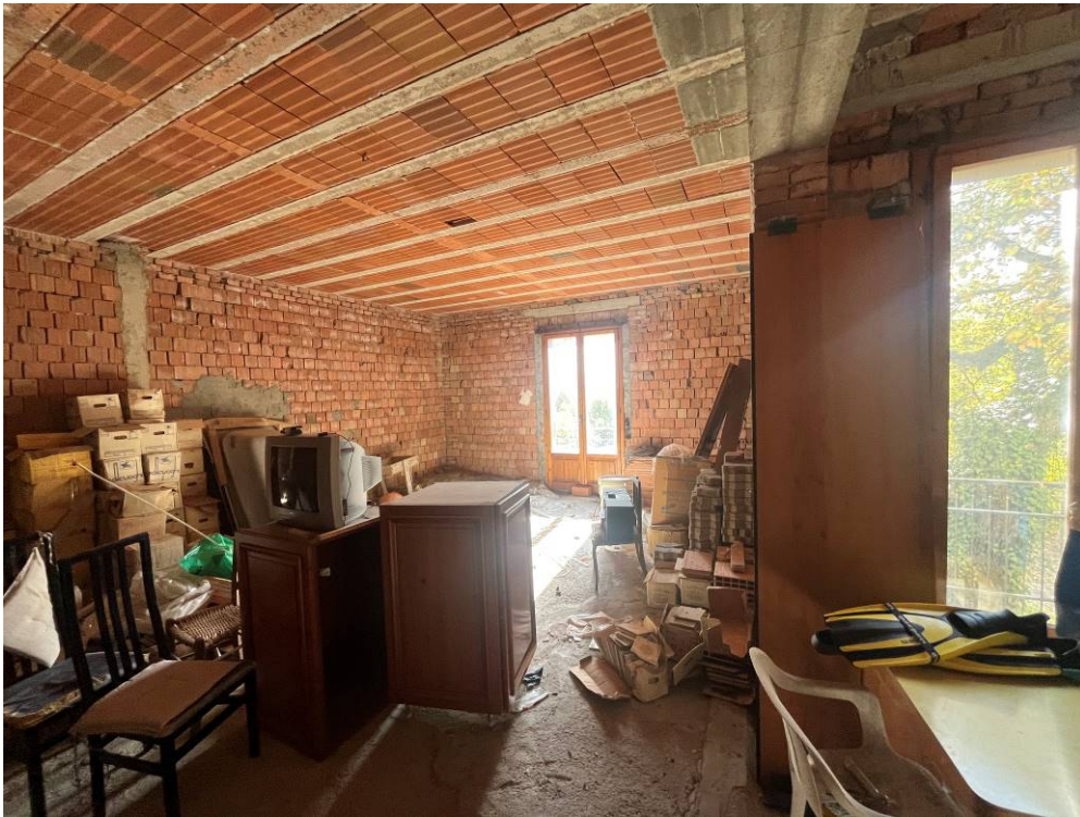
22. Magazzino in stato al grezzo
