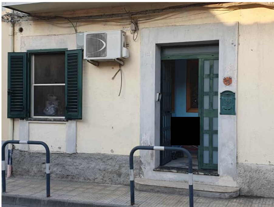
Foto 1: Facciata dell'immobile con porta a vetro ed alluminio e finestra con persiana in alluminio
