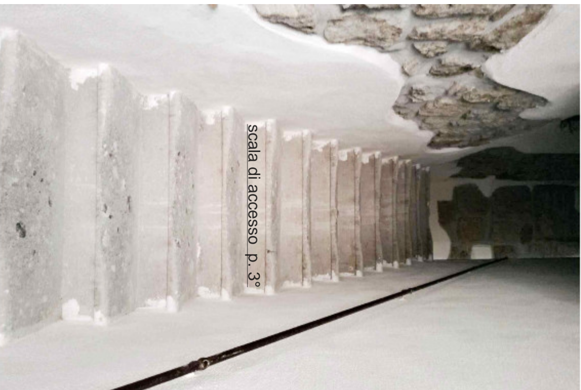
SCALA DI ACCESSO
