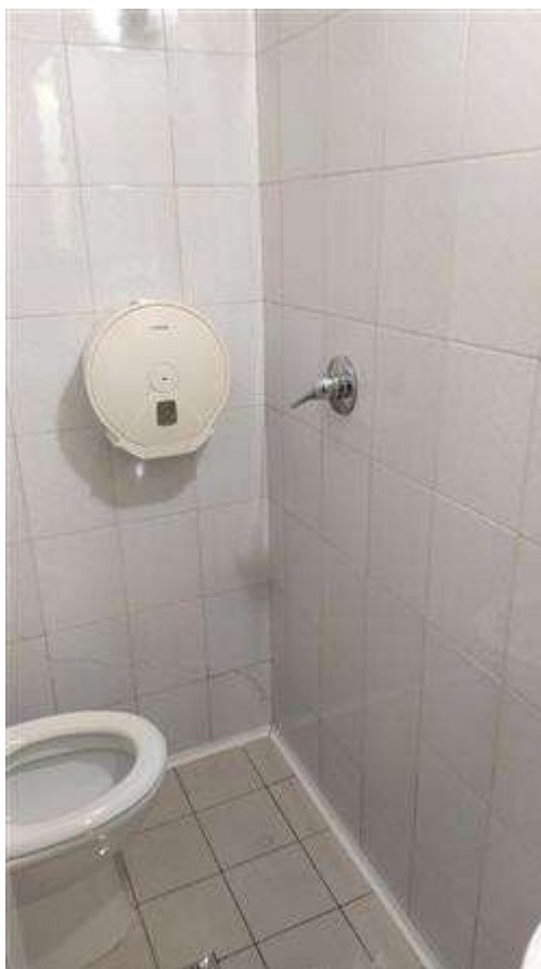
interno locale bagno
