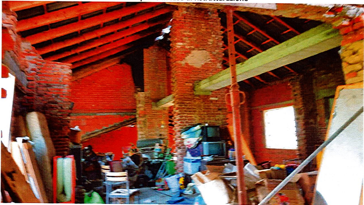
Primo piano in fase di ristrutturazione
