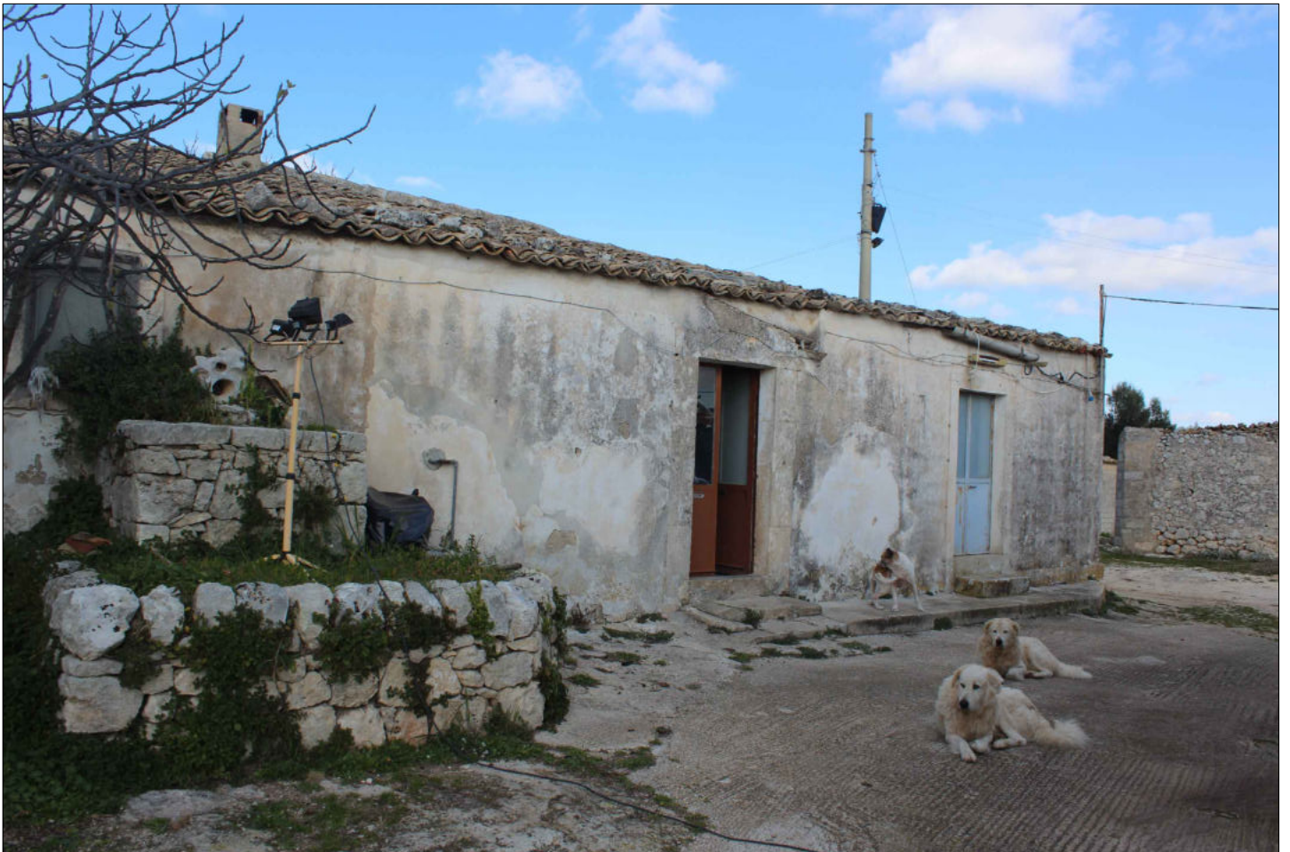
10) Fabbricato rurale (non censito in catasto) Foglio 160 P.lle 35-36-37-106 Lato Est
