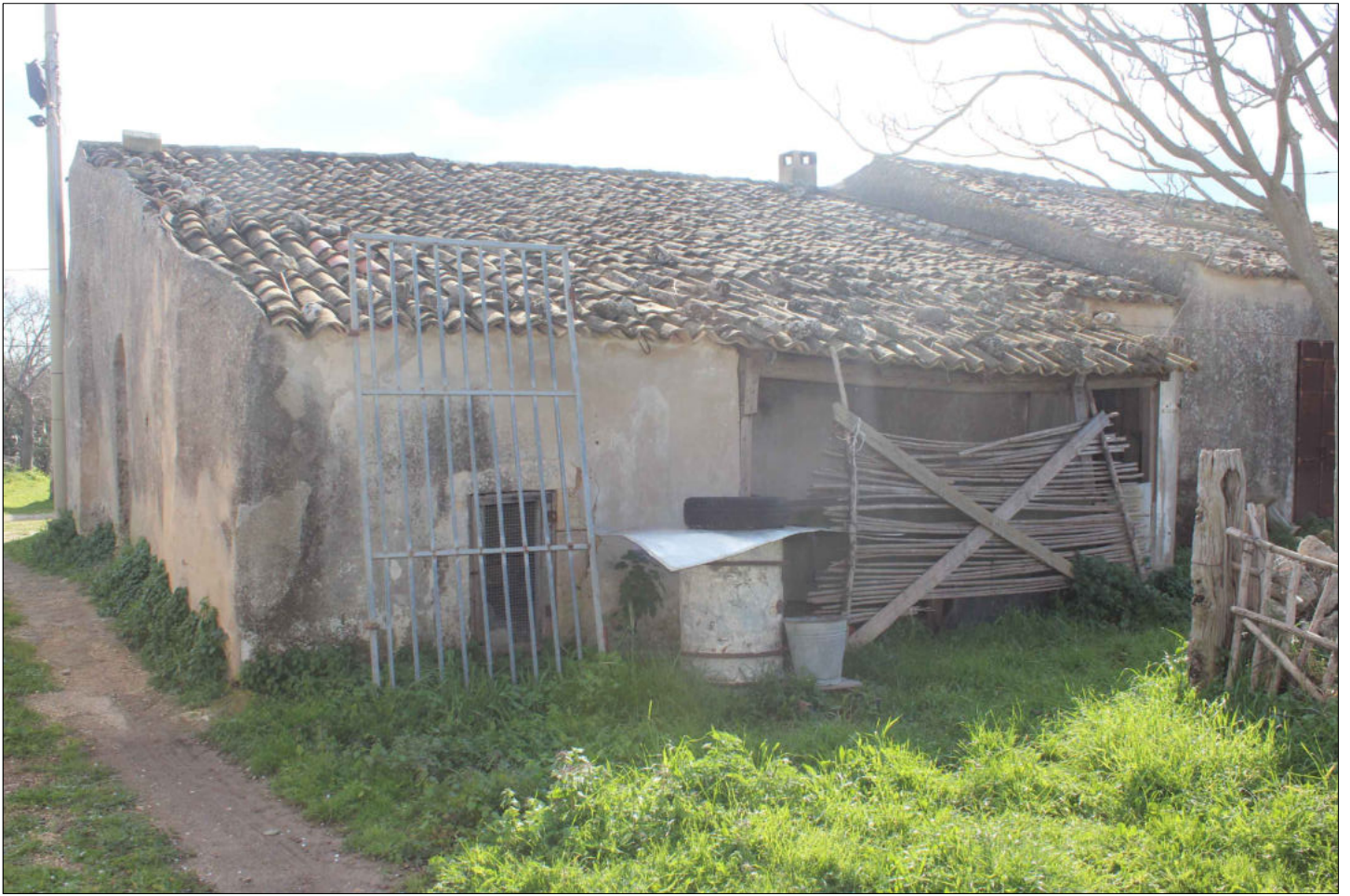
11) Fabbricato rurale (non censito in catasto) Foglio 160 P.lle 35-36-37-106 Angolo Nord-Ovest
