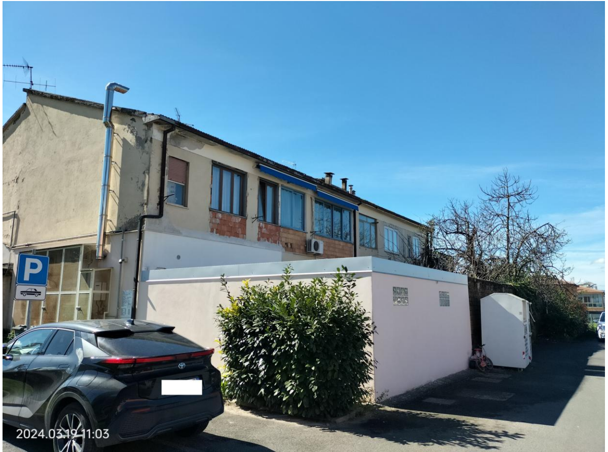
ripresa laterale/retro fabbricato
