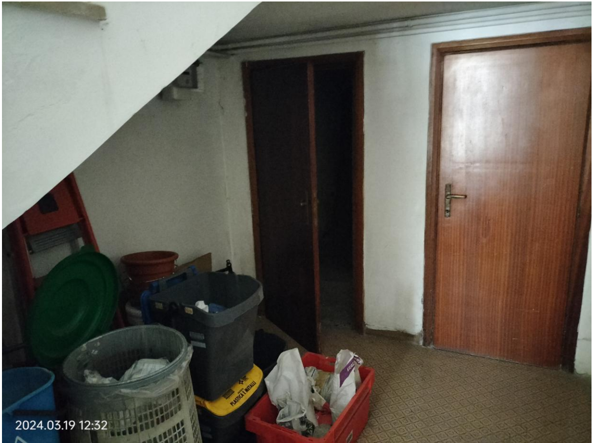
accesso locale cantina al piano terra dal vano scala comune
