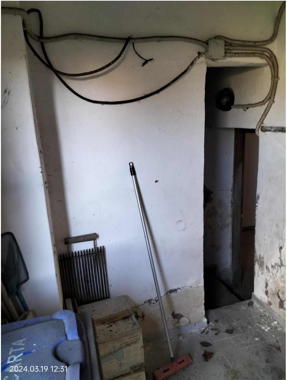
interno locale cantina piano terra
