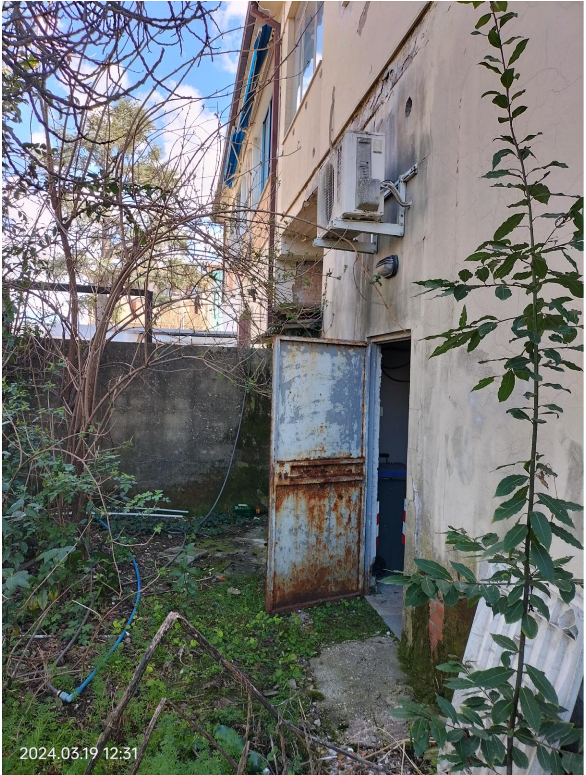
ripresa esterna cantina piano terra, con porta di accesso al cortile sul retro del fabbricato, appartenente ad altra ditta (non interessato dalla procedura)
