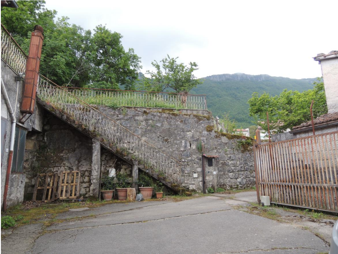
Figura 36_scala esterna di accesso terrazzo
