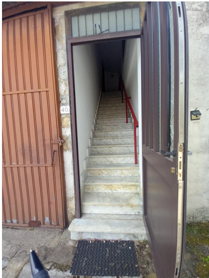
Figura 20_scala di accesso al sub.4
