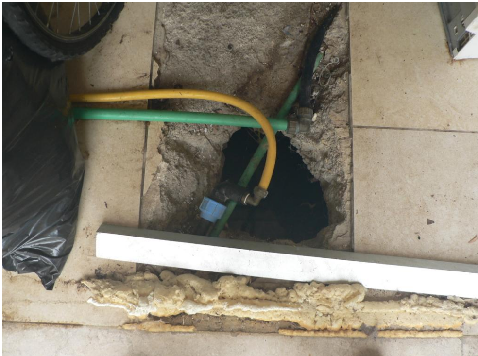
Fotogramma n. 16 Foro aspirazione acqua dalle fondazioni - Garage
