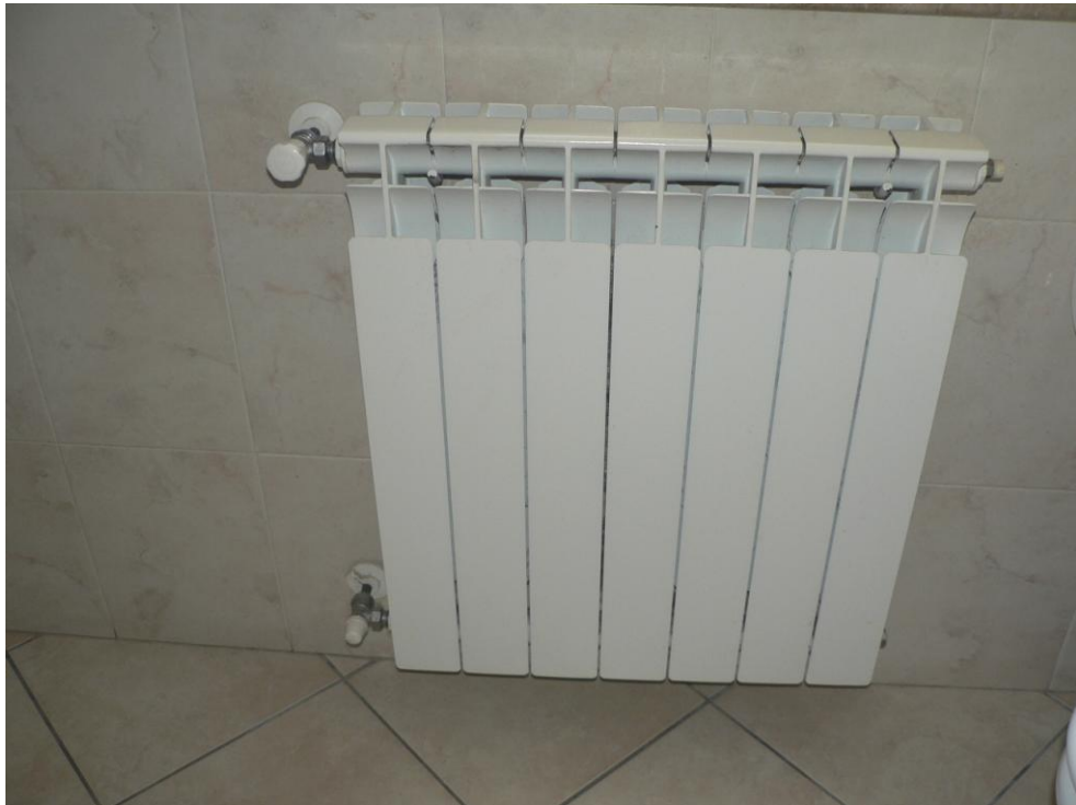
Fotogramma n. 9 Bagno Piano Primo
