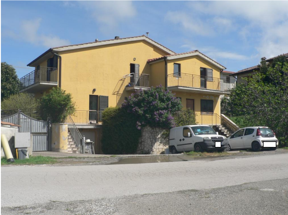
Fotogramma n. 3 Prospetto Lato Sud
