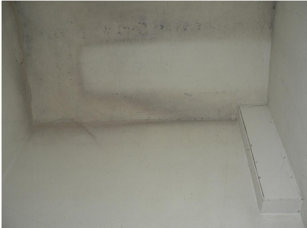
Fotogramma n. 15 Soffitto Camera Piano Primo
