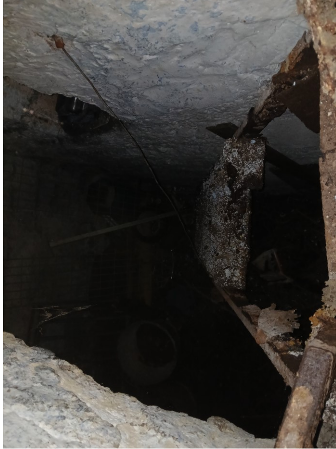
Foto 6 Vista Interna Interna Cantina “Non Ispezionata”
