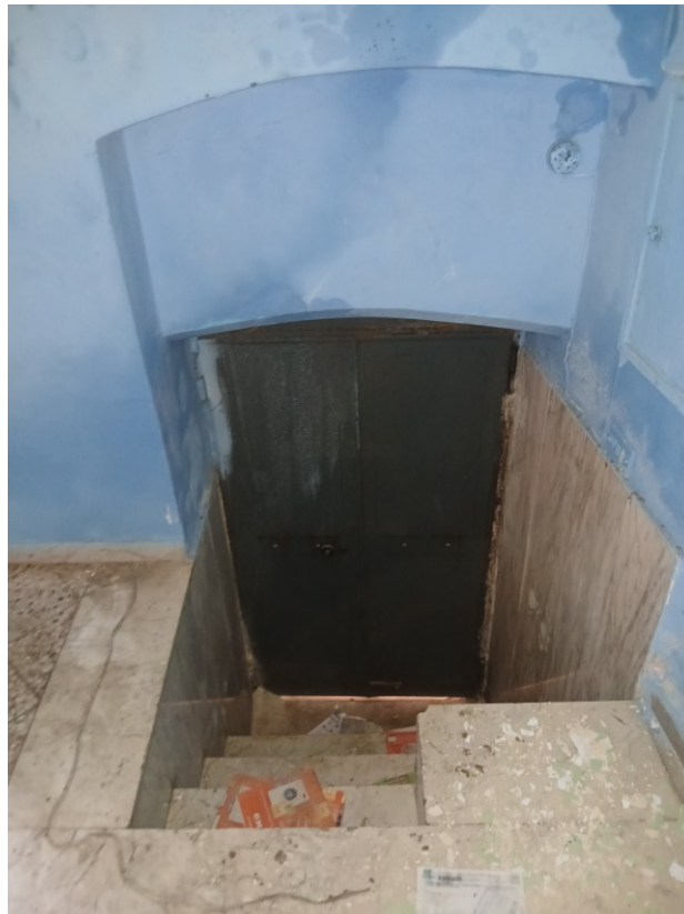
Foto 7 Vista Interna Accesso Piano rialzato da via Gioscia
