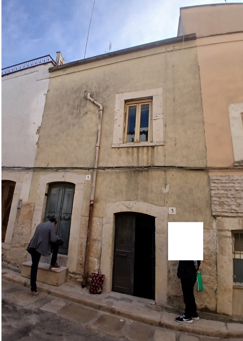
Foto 1 Vista Edificio Residenziale, accesso via Nicola Gioscia
