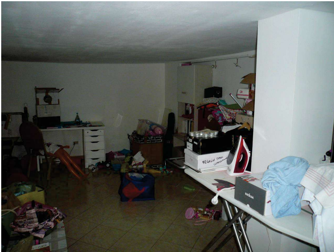
Figura 11 - Particolare locali al piano terra
