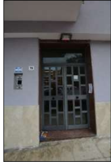
All. 14 – Foto 1 Ingresso edificio di Via F. Speciale n. 79
