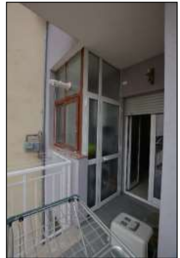
All. 14 – Foto 20 Balcone (4) e veranda (2)
