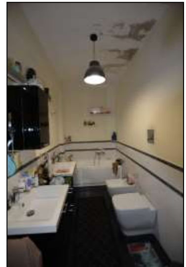
All. 14 – Foto 14 Wc bagno
