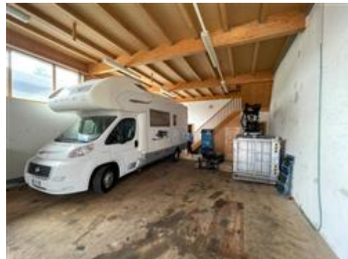
Magazzino lato ovest
