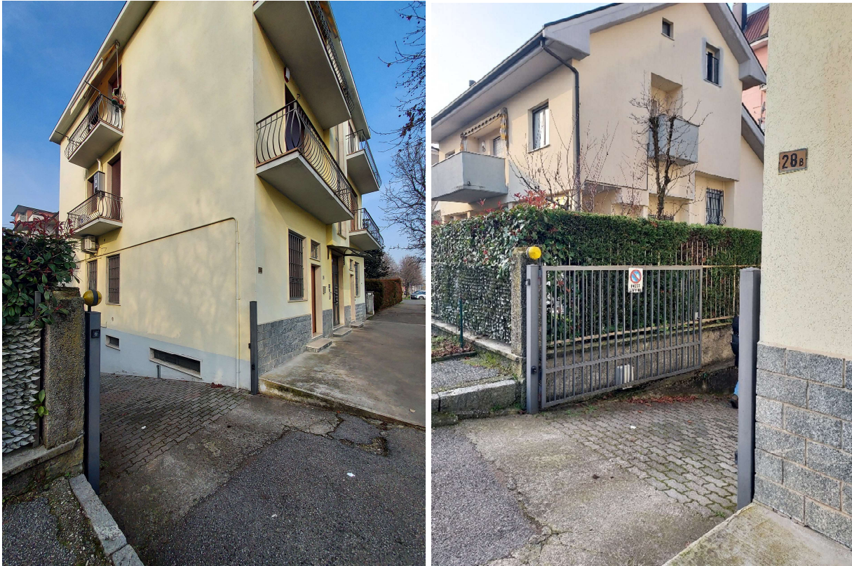
Vista da Via Quintino di Vona
