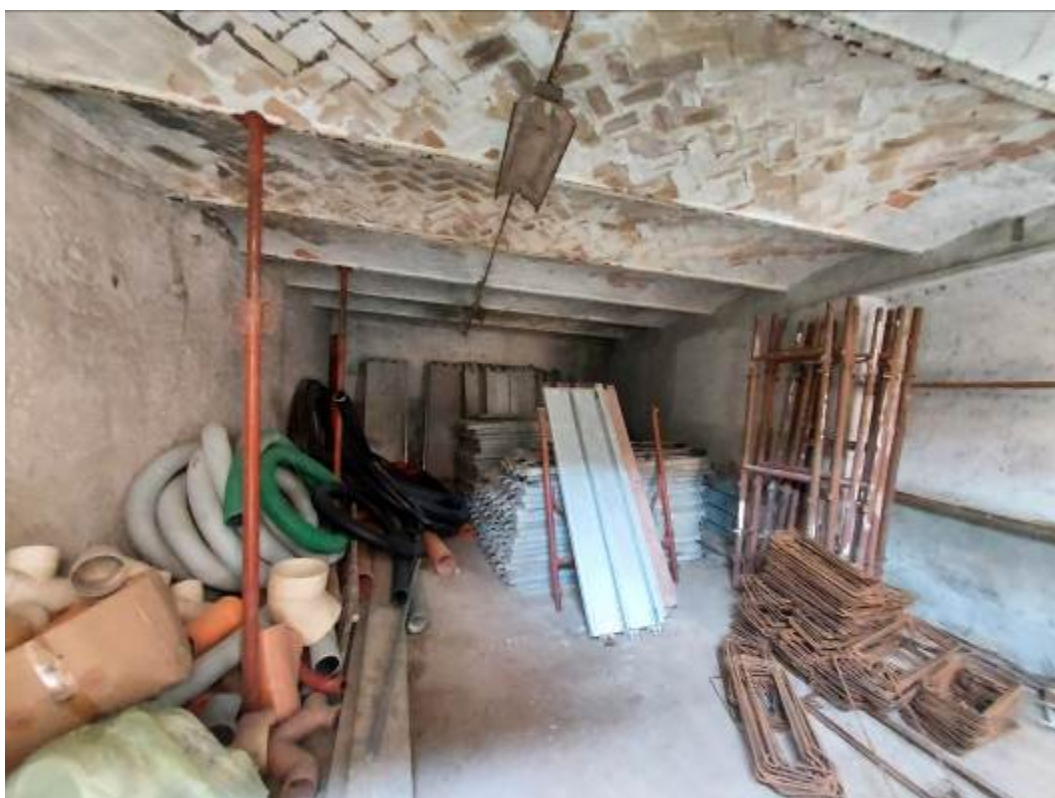
CORPO 5b – Deposito Vista interna piano terra
