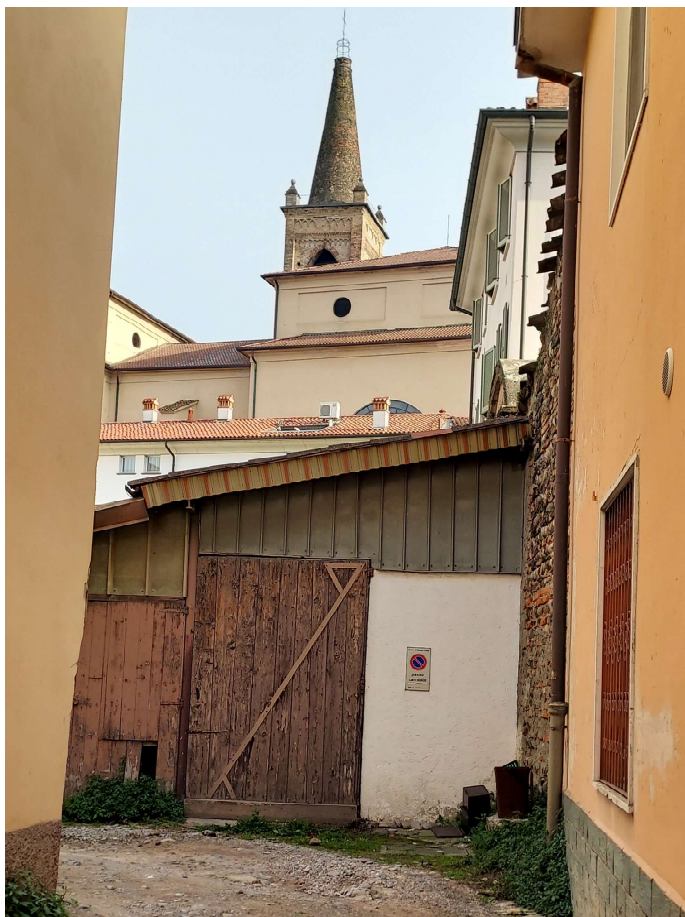
CORPO 5a - Magazzino 5a.1
