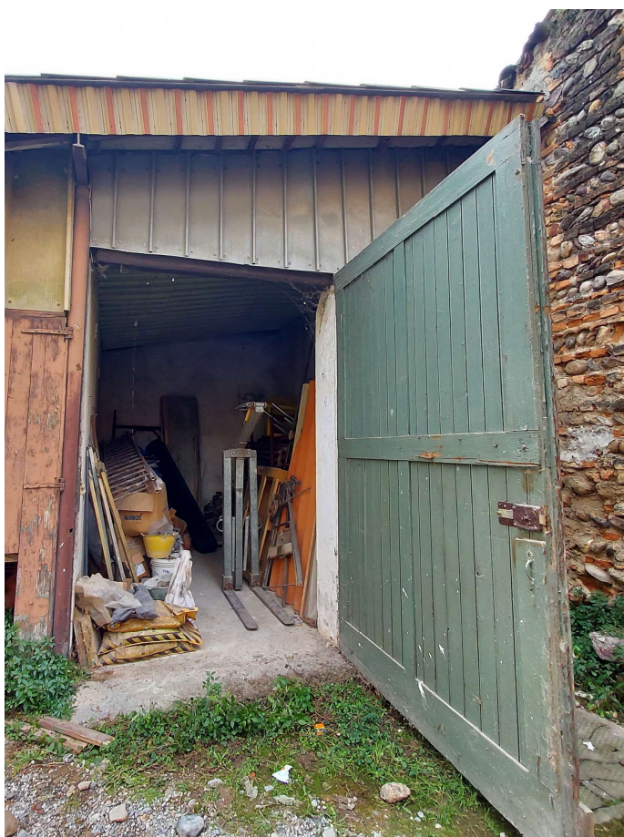
CORPO 5a - Magazzino 5a.1
