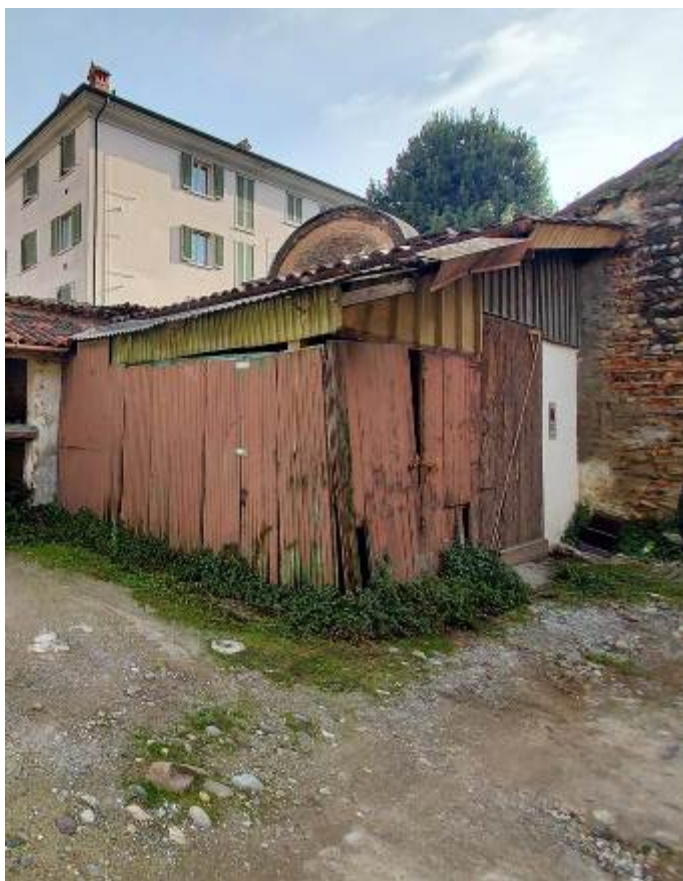
CORPO 5a - Magazzino 5a.2
