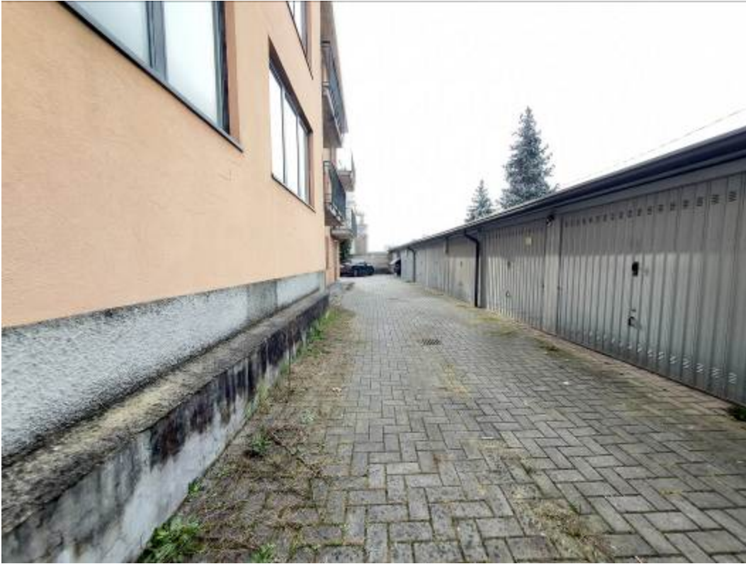
Corsello di manovra dei box
