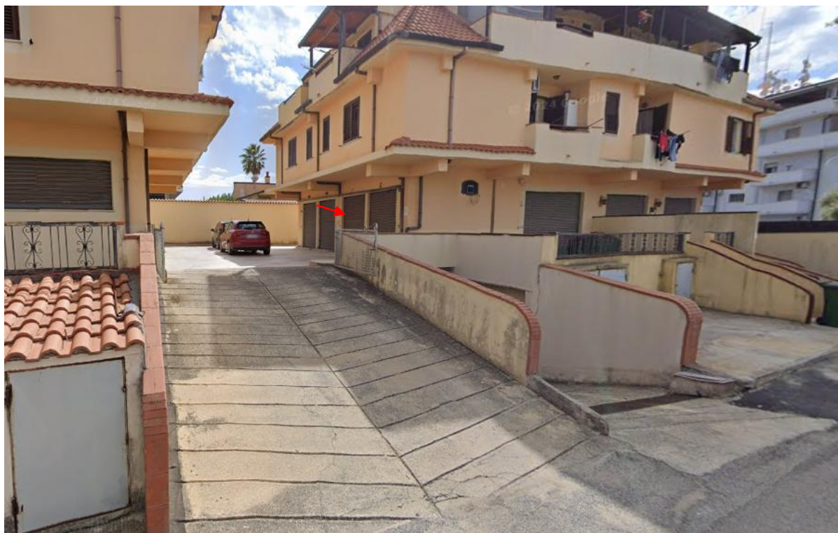
Foto n. 4: Garage part. 721 sub 22- fabbricato corpo "A"
