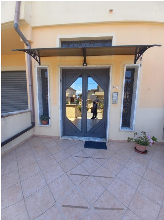
Foto n. 5: Ingresso vano scala
