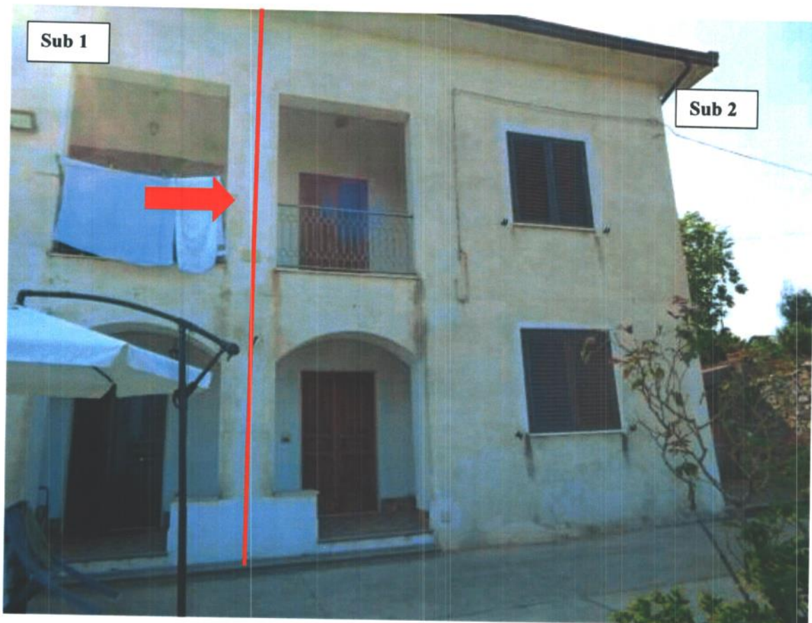
Immagine 1 Vista del fabbricato, lato ovest vialetto di accesso comune al sub 1- 2
