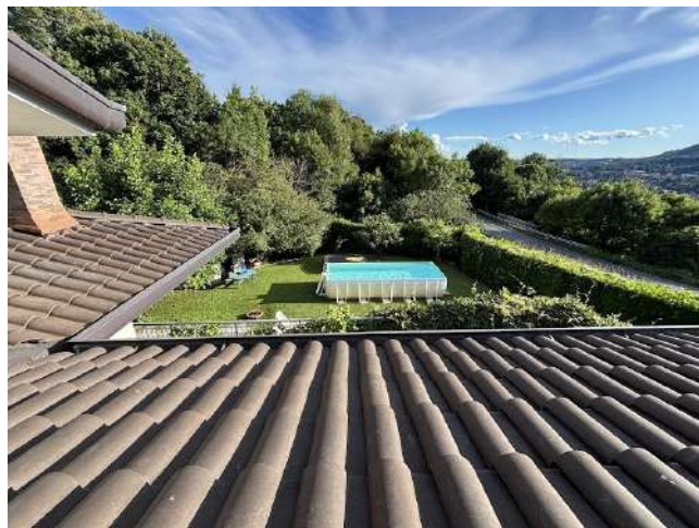
Giardino visto dal sottotetto
