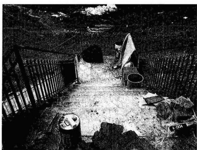
Edificio part.IIa 296 sub2
