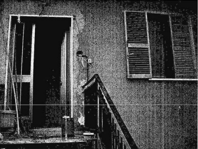
Edificio part.IIa 296 sub2
