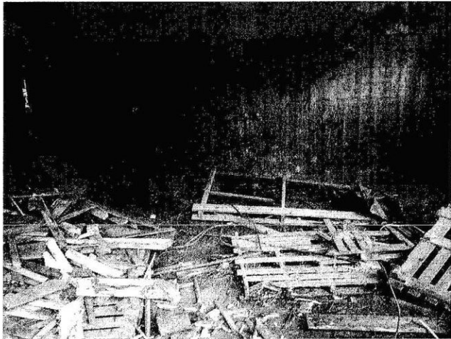
Edificio part.IIa 413 Deposito mangimi
