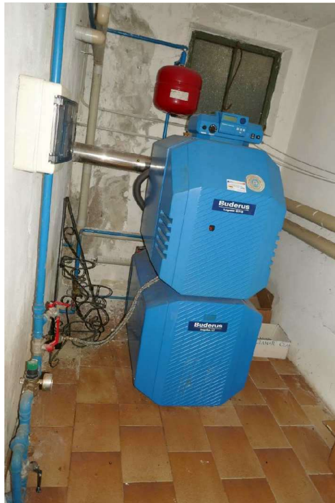
Centrale termica con la caldaia a gasolio di ottima qualità (marca BUDERUS) che, nonostante gli anni (20-25) presenta ancora una buona efficienza energetica.
