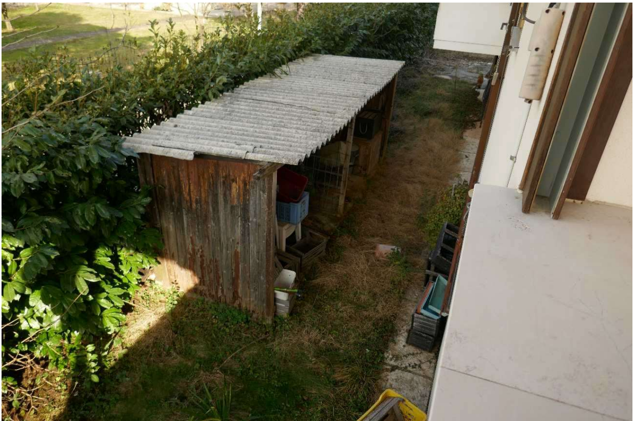
Zona ad ovest con in primo piano la copertura in eternit della tettoia.
