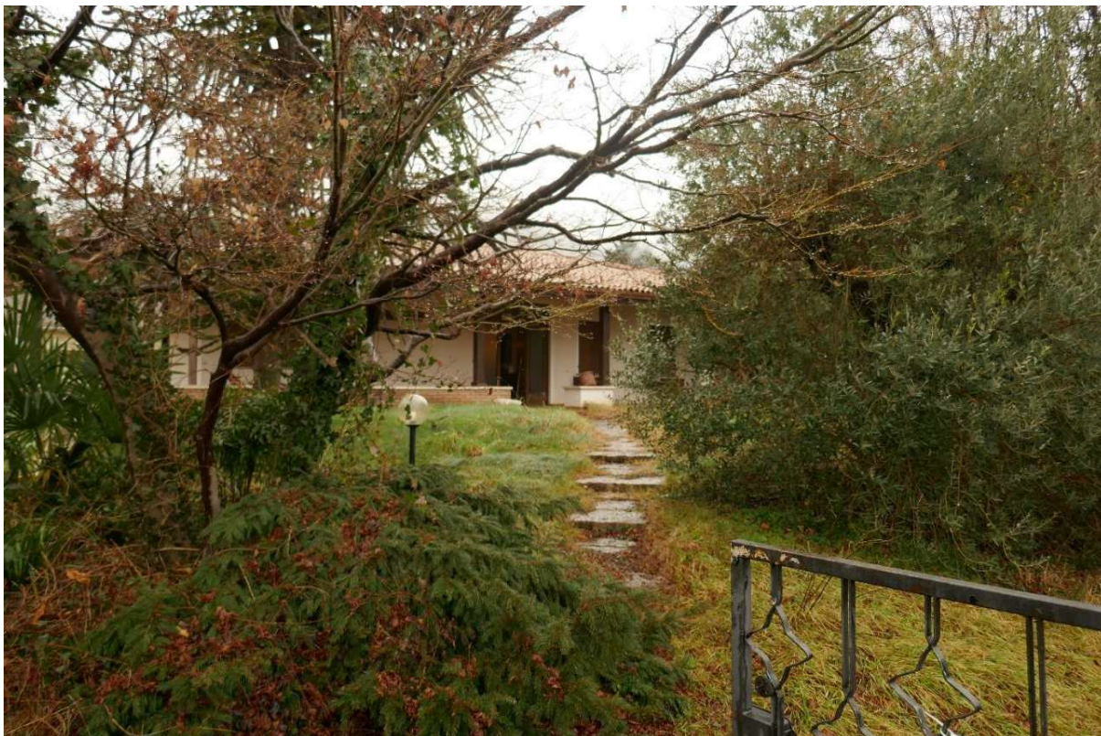
Dal cancello pedonale fino alla abitazione sono state posizionate delle pregevoli plotte in pietra che vanno a formare alcuni gradini, rendendo eventualmente più difficile l'accesso ai disabili motori.
