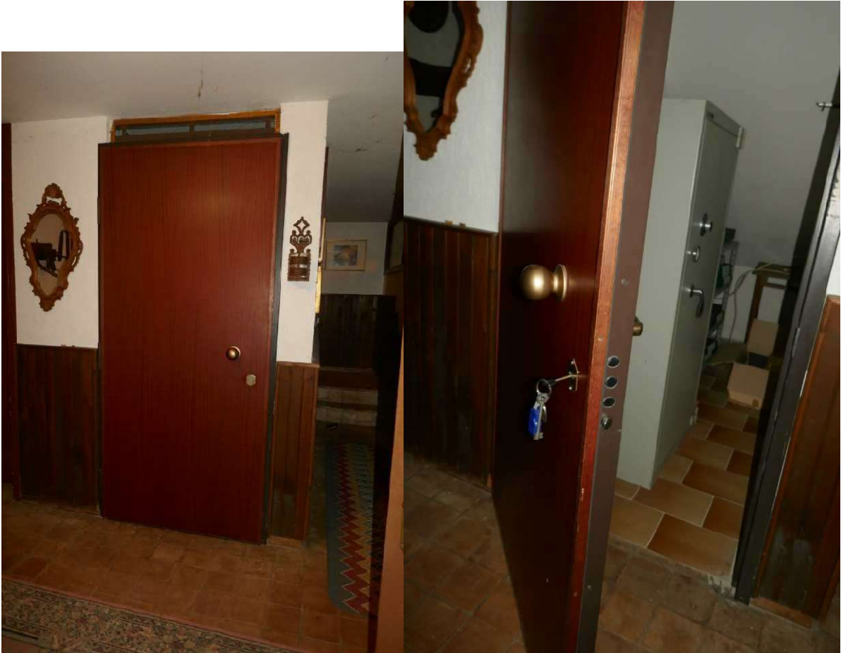
Il sottoscala è tamponato con una porta blindata ed all'interno è collocata una cassaforte.
