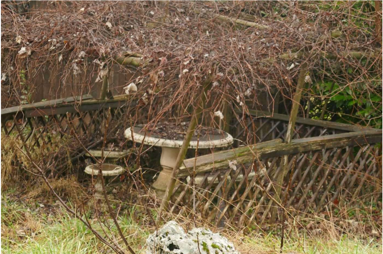
Nella parte sud-ovest del giardino c'è un gazebo, con struttura in legno ormai quasi completamente collassata, con tavolino e panche in cemento.
