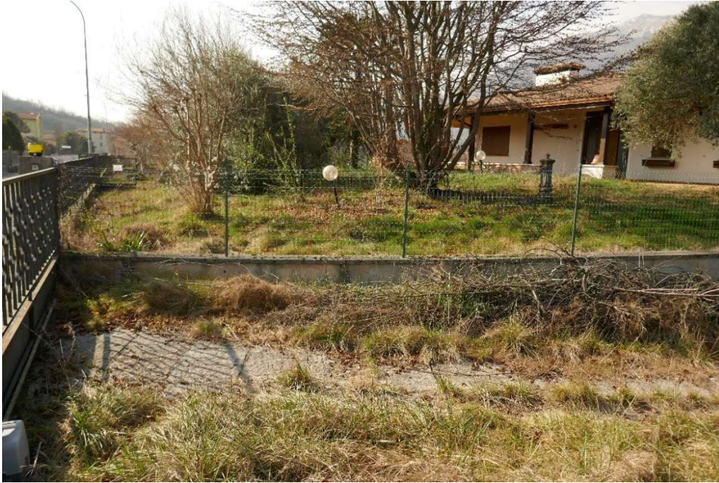
Zona nord-est del giardino e particolare della zona del cancello carraio scorrevole, del quale si intravede il motore elettrico in basso a Sx.
