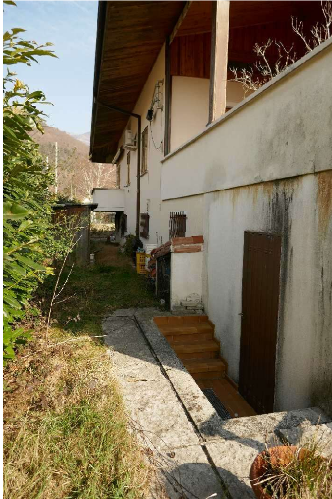
Tramite i 4 gradini, e la porta in lamiera verniciata, si può accedere allo stanzino-laboratorio sito nel seminterrato.
