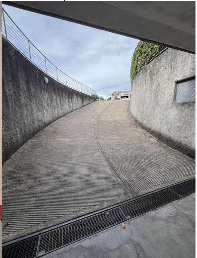
Rampa accesso autorimessa
