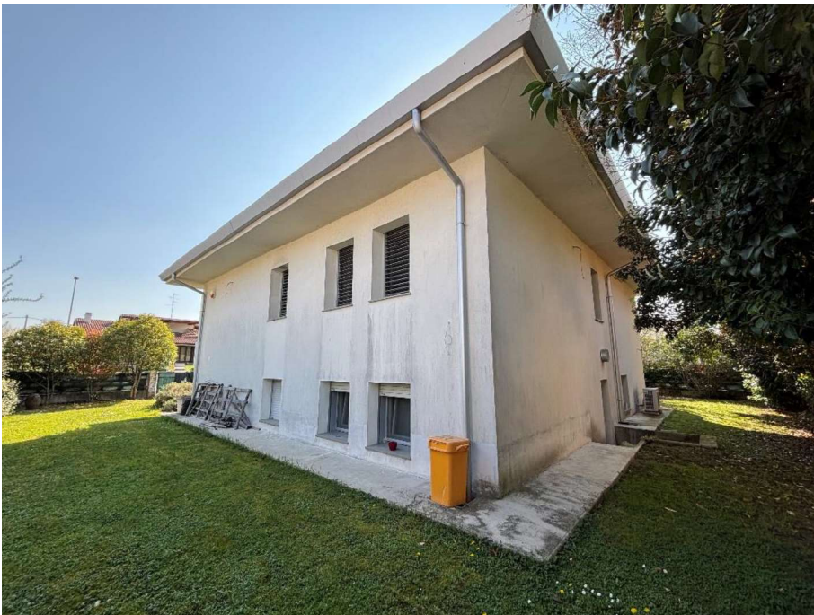
Vista esterna laterale da interno proprietà
