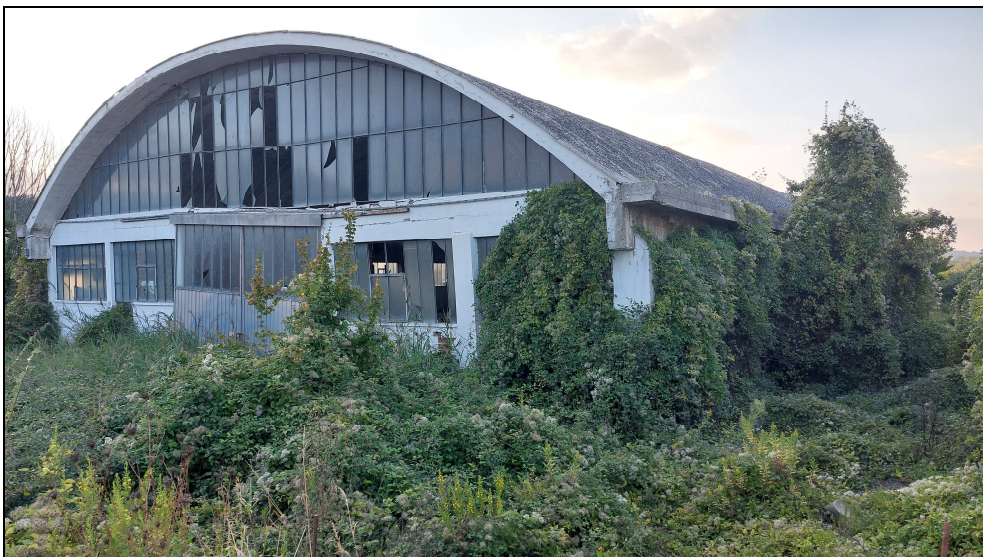
Immagine 10 – Fronte e fianco destro attuale.
